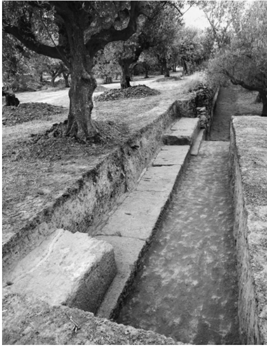
Είκ. 19. Ίδιοκτησία Ν. Δικαίου. Τομή VIII. Αναλημματικός τοίχος Β. Άποψη από Β.
