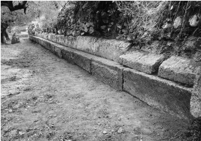
Είκ. 18. Ίδιοκτησία Ν. Δικαίου. Όρατός άναλημματικός τοίχος Β μετά τόν καθαρισμό του.
