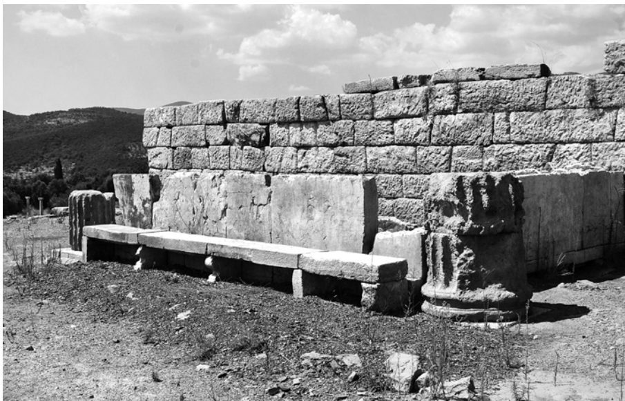
Είκ. 3. Τò βήμα με τὸ ἔδρανο μετὰ τὴν ἀποκατάστασή του.
