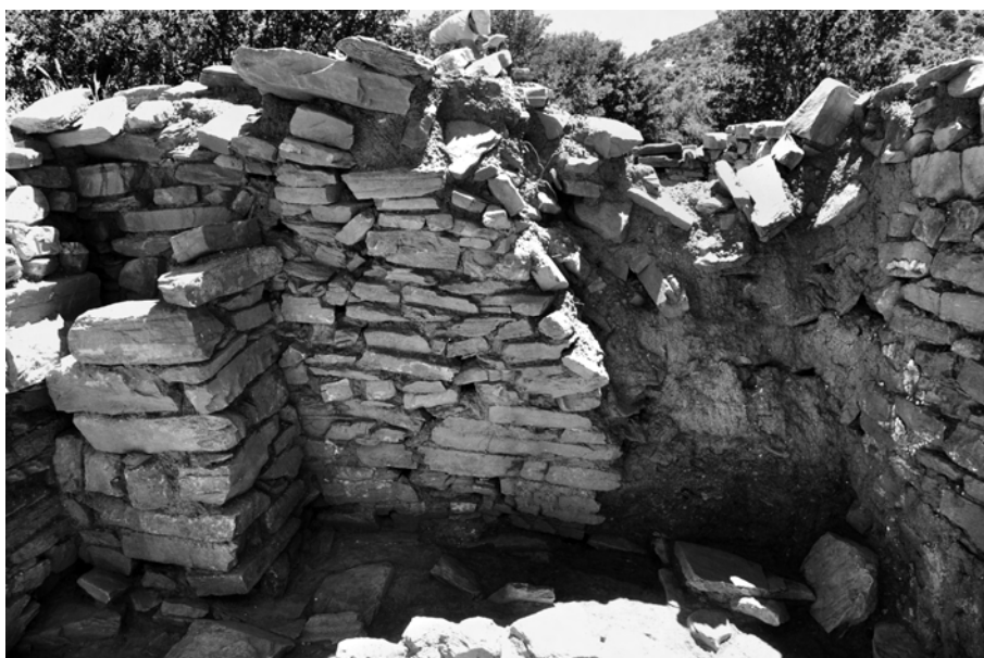
Είχ. 9. Φράξιμο τῆς θύρας μεταξύ τῶν Χώρων 8 καὶ 9.
