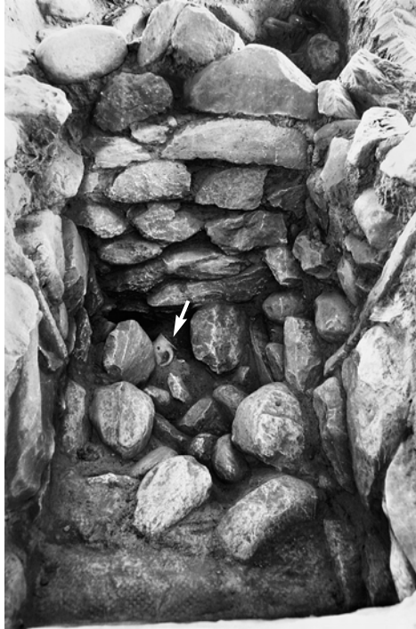
Εἰκ. 7. Τάφος 55. Πέτρες στὸ χεῖλος ὠοειδοῦς κοίλου μέσα στὸ πρόθυρο καὶ πρόγους στὸν πυθμένα σηματοδμεμένες με βέλος, ἀπὸ Α.
