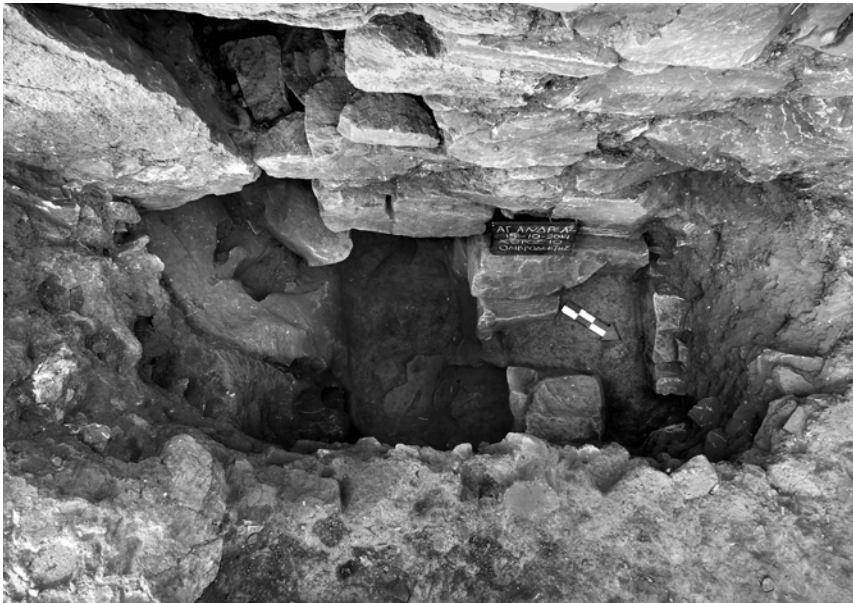
Εἰκ. 4. Περιοχὴ μυκηναϊκῆς οἰκίας Η, ὁ χῶρος 10 (συγκρότημα Ν). Ἐσωτερικὴ παρειά τοῦ ἐσωτερικοῦ τείχους. Τὰ ἀνοίγματα καὶ ὁ ὀμβροδέκτης.
