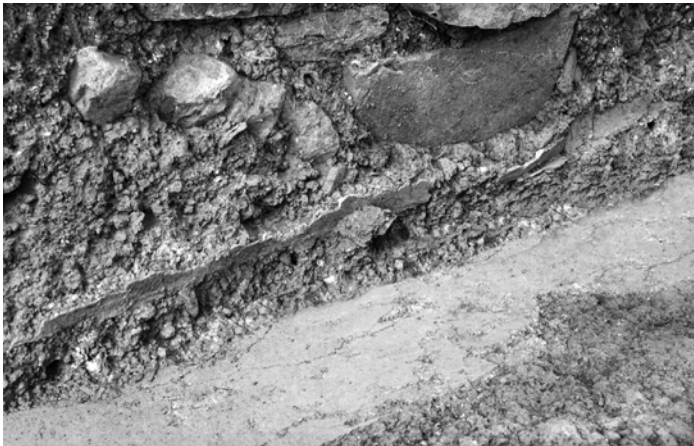
Εἰκ. 7. Ἐπικονιαμένο δάπεδο καὶ τοῖχος στὸ ἐσωτερικὸ τοῦ δωματίου ΝΑ. τοῦ Χώρου 1 (ἀπὸ ΝΔ.).
