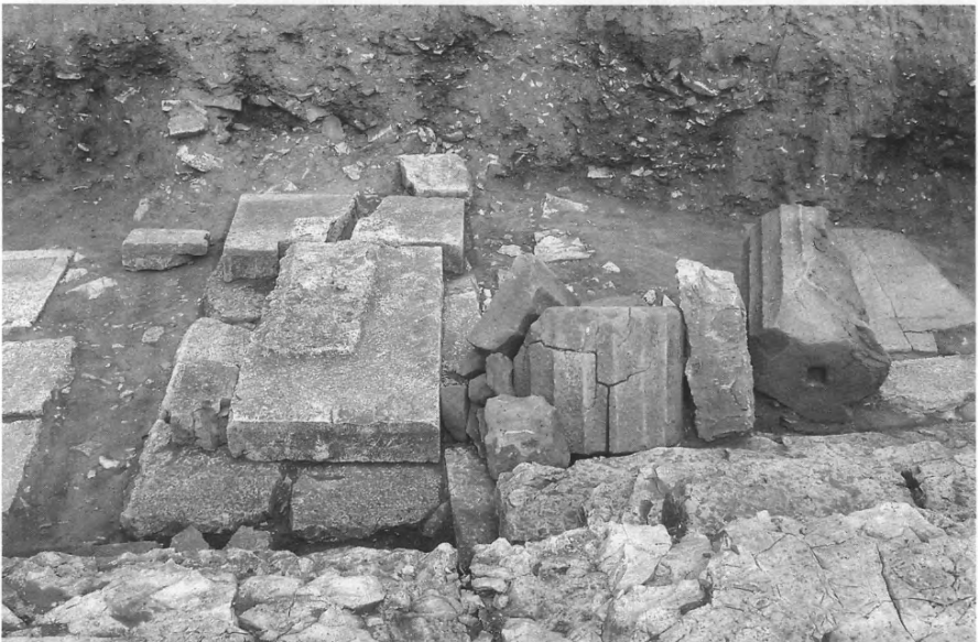
α-β. Δυτική στοά, νότιο σκέλος: α. Τόρμος και αὔλακα μολυβδοχόησης στὸν στυλοβάτη τῆς ἀνατολικῆς ὄψης. β. Τμήματα σφονδύλων ἀπὸ ψαμμιτόλιθο ἐπὶ τῆς κλίμακας 2 καὶ τῶν βάθρων 5-6 ἀπὸ Δ.
