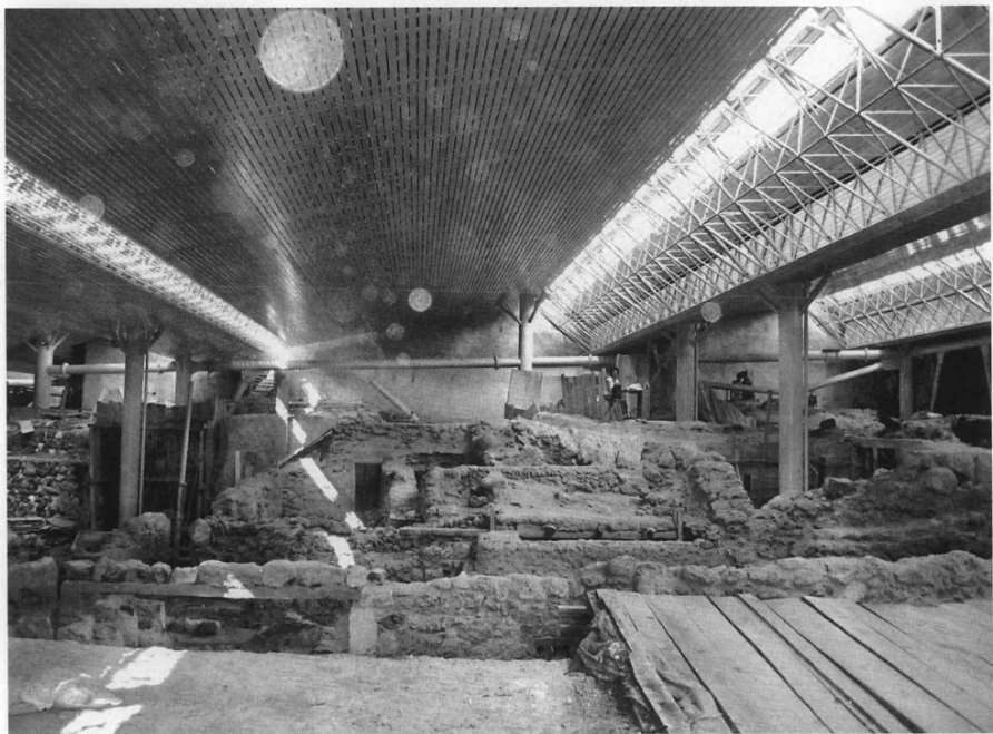
α. Ψευδοροφή στο βόρειο τμήμα. β. Τμήμα μεταξύ τῶν πεσσοστοιχιῶν Δ12 καὶ Δ14.
