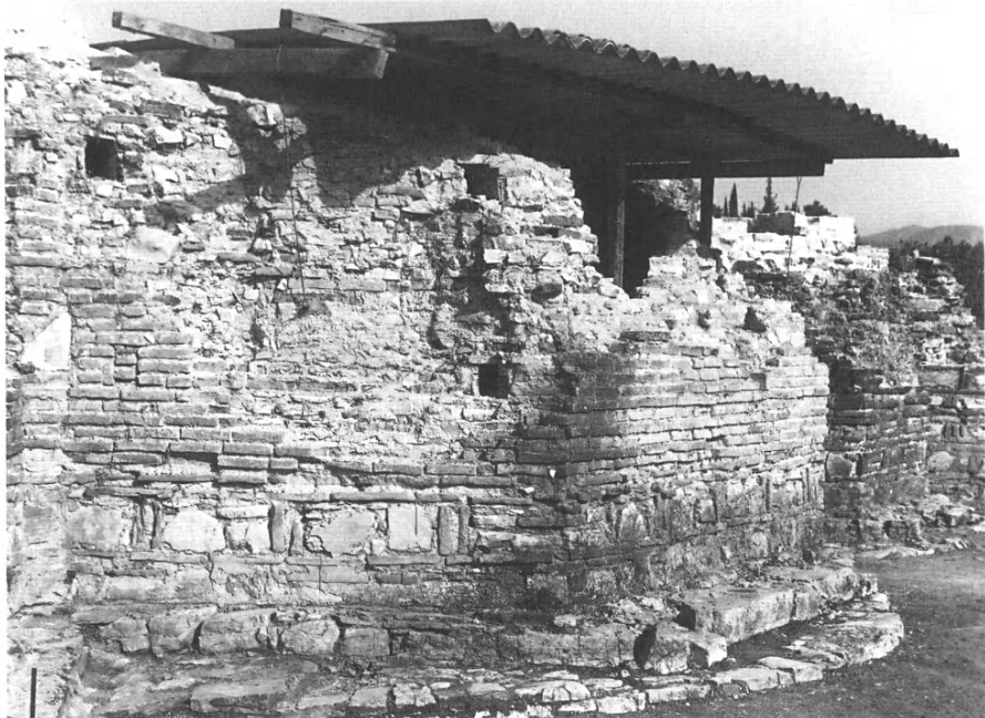
α. Τὸ στέγαστρο τοῦ ΒΔ γωνιαίου διαμερίσματος ἀπὸ ΝΑ. β. Ἡ τρίπλευρη κεντρικὴ ἀψίδα μετὰ τὴν ἀποκάλυψη τῆς καμπύλης ὑποθεμελιώσεως.
