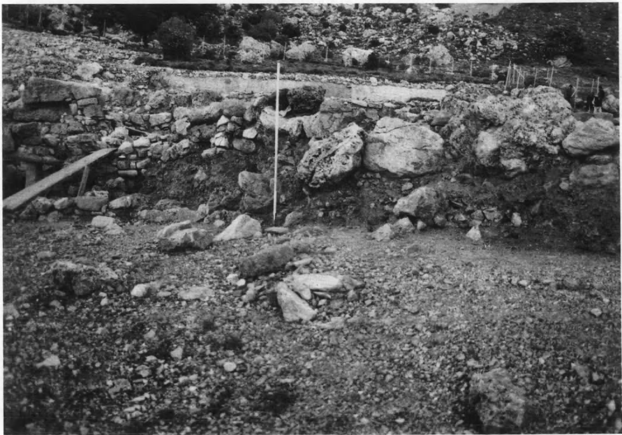
α. Τὸ μέτωπο τοῦ ἀνδῆρου IIIA μετὴν ξερολιθιά ἀντιστήριξης τῆς ἐπίχωσης ὅπου ἐδράζεται (ἀπὸ ΒΔ). β. Οἱ ὀγκόλιθοι τοῦ μετώπου τοῦ ἀνδῆρου IIIA σὲ σχέση μετὴν χαλαρῆ ἐπίχωση ἔδρασης (ἀπὸ Δ).
