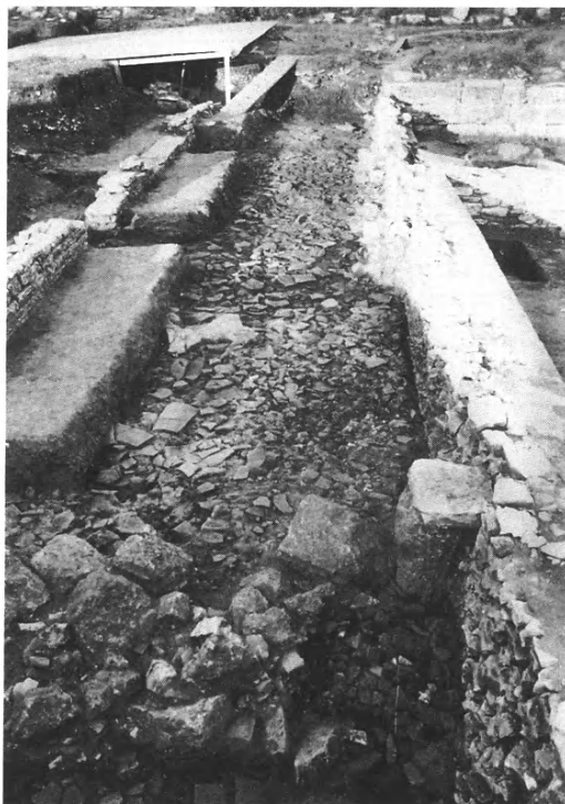
α. Πρυτανεῖο, διάδρομος τῆς πτέρυγας Ο2, πρὸ τῶν δωματίων δ' καὶ ε'. ᾠΑποψη ἀπὸ Ν. Ἡ πίσω ὄψη τοῦ τοίχου Α2''-Θ καὶ τὸ στρώμα καταστροφῆς. β. Πρὸ τῶν δωματίων δ', ε' καὶ ζ'. ᾠΑποψη ἀπὸ Α. Ἡ πίσω ὄψη τοῦ τοίχου Α2''-Θ μὲ τὶς ἀντηρίδες καὶ τὸ στρώμα καταστροφῆς.
