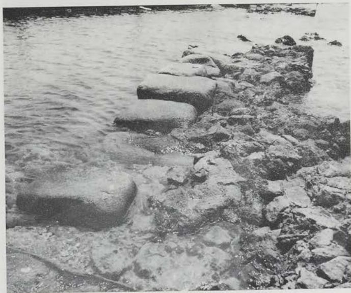
α. Όψη τμήματος του μεταγενέστερου (μεσαιωνικού;) λιμενικού έργου του τομέα Β από τα νότια. β. Άλλη όψη του μεταγενέστερου λιμενικού έργου του τομέα Β από ΝΔ.
