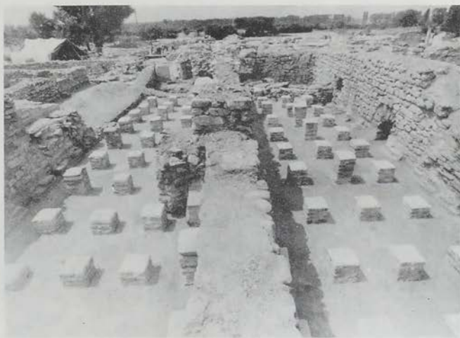
α. Τὸ ὑπόκαυστο τοῦ λουτροῦ. β. Τὰ λουτρά. Ὁ «μέσος οἶκος» μετὰ τὴ συντήρησιν.
