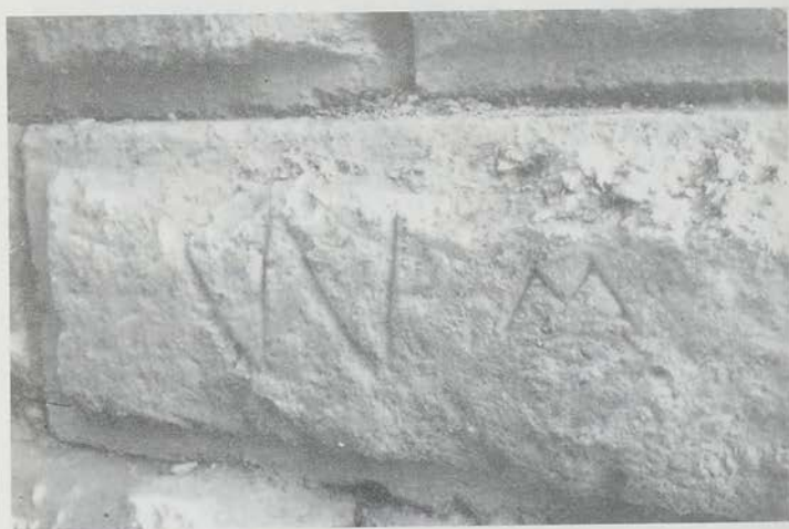
α. Τμήμα κλασικού τείχους της ανατ. πλευράς. Ήξοτ. πλευρά. β. Γράμματα οικόδομων σε λιθόπλιθο ισοδομικού τείχους.
