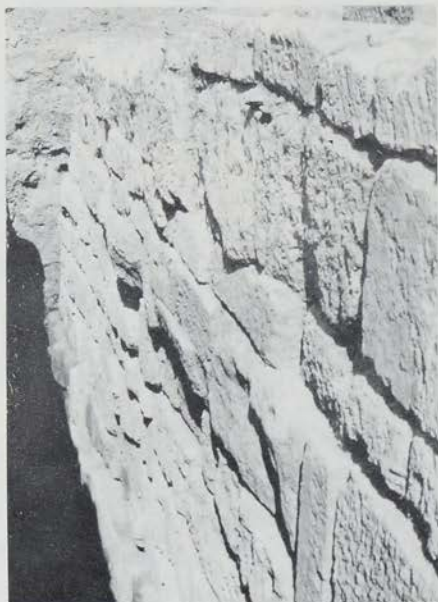
α. Ὁ νότιος τοῖχος τοῦ πύργου καὶ τὸ τεῖχος νότια ἀπὸ αὐτόν. β. Ὁ νότιος τοῖχος προμαχώνα ἢ ἀναλήματος.
