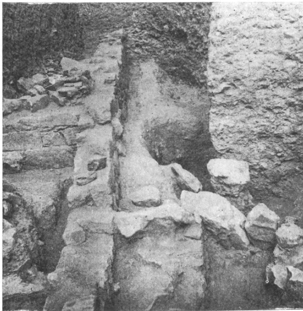
Εἰκ. 3. Ἀπομῆς τῶν ἐρειπίων. Ὁ μέγας ἀνατολικὸς τοῖχος Σ καὶ οἱ ἐγκάρσιοι τοῖχοι Β καὶ Γ.
