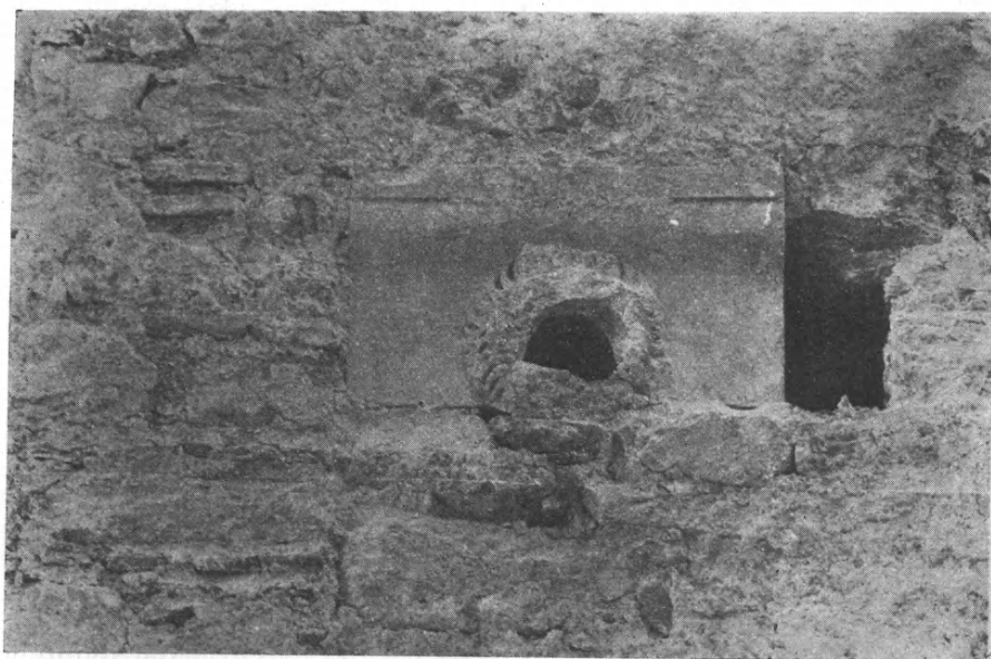
Είκ. 10. Άρχαϊα ύδρορροή έντετοιχισμένη επί τής Ν πλευράς.
