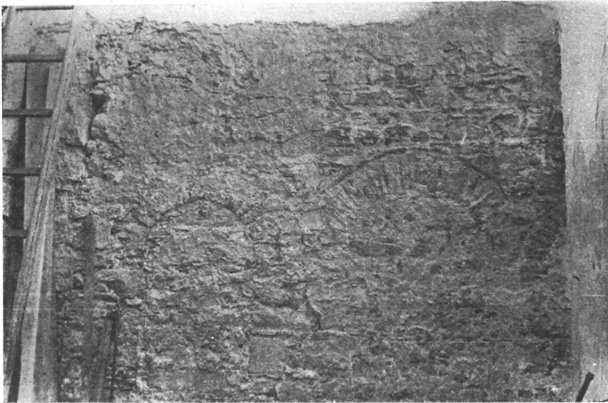
Εἰκ. 7. Βυζαντινὰ τόξα ἐπὶ τῆς ἐντοιχίσεως τῶν ἀρχικῶν ἀνοιγμάτων.
