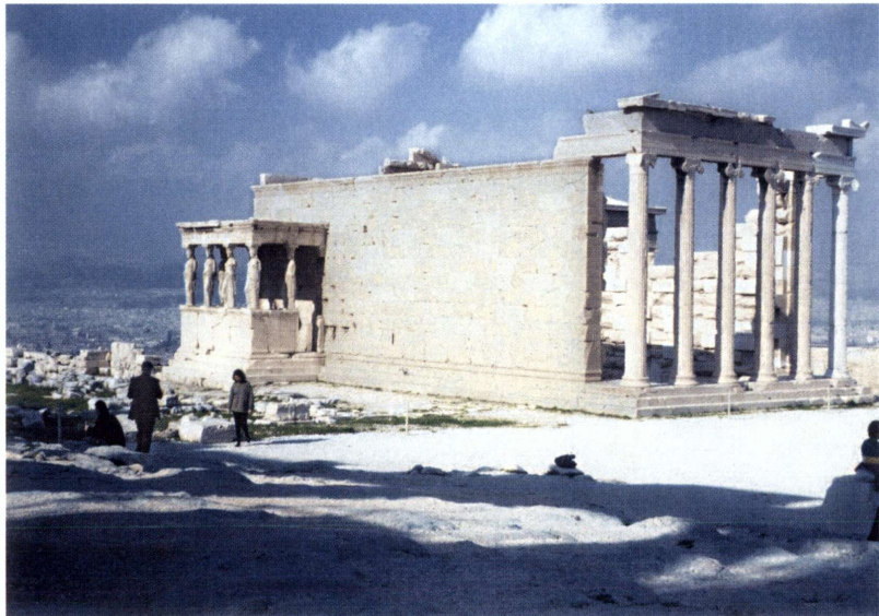
Είκ. 2. Έρεχθειον. Η νότια πλευρά με την πρόταση των Καρυστίδων και η ανατολική όψη του όπως άναστηλώθηκε.
