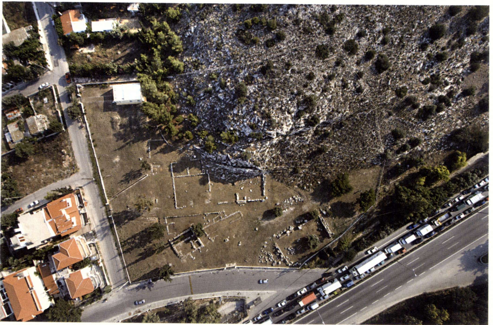
Τὰ εἱρεῖνα τοῦ ἱεροῦ τῆς Ἀφροδίτης καὶ τοῦ Ἔρωτος στὴν Ἱερὰ Ὁδό. Ἄεροφωτογραφία.
