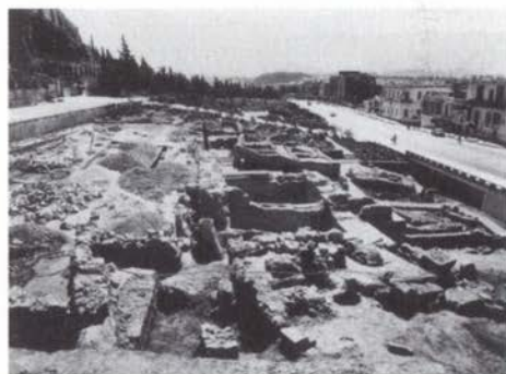
134. Ἀνασκαφὴ ἐμπρὸς ἀπὸ τὸ Ὁδεῖο Ἡρώδου Ἀττικοῦ, 1955 (ΑΕ 2002, 28, εἰκ. 28).
