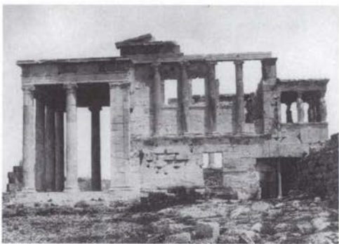
58. Ἡ δυτικὴ πλευρὰ τοῦ Ἐρεχθείου μετὰ τὴν ἀναστήλωση κατὰ τὸ 1902-1909 (ΦΑΕ 364).
