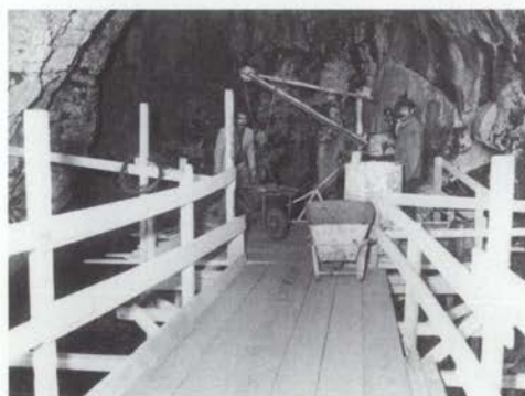
288. Ίδαϊον Άντρον, Κρήτη. Ξύλινος ἐναέριος διάδρομος-οκαλωσιά, γιὰ τὴν ἀνασκαφή τοῦ σπηλαίου (ΙΑΕ 1983, πίν. 257α).
