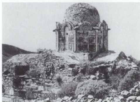
226. Σταυρή Κίττας Μάνης. Η νότια πλευρά του ναού της Έποκοπής, των χρόνων περί το 1200, πριν από τις εργασίες στερέωσης.
