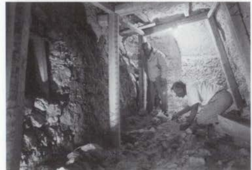
153. 'Ακρωτήρι Θήρας. 'Ο Σπυρίδων Μαρινάτος και ο 'Ιωάννης Καραμητρος στη σήραγγα της όδοϋ της 'Ανωφερείας.
