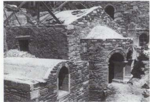
130. Πάρος, Καταπολιανή, 1964. Τὸ ἀναστηλωμένο παλααιοχριστιανικὸ βαπτιστήριο (ΠΑΕ 1964, πίν. 175).
