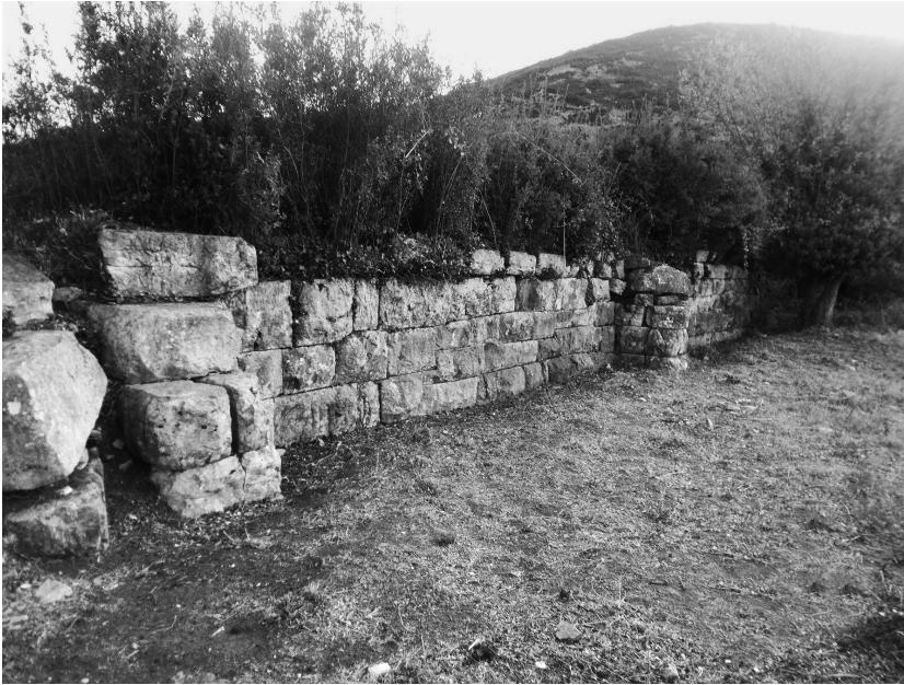
41. Θέρμος. Άποψη τοῦ ὀπίσθιου τοίχου τῆς νότιας στοᾶς.
