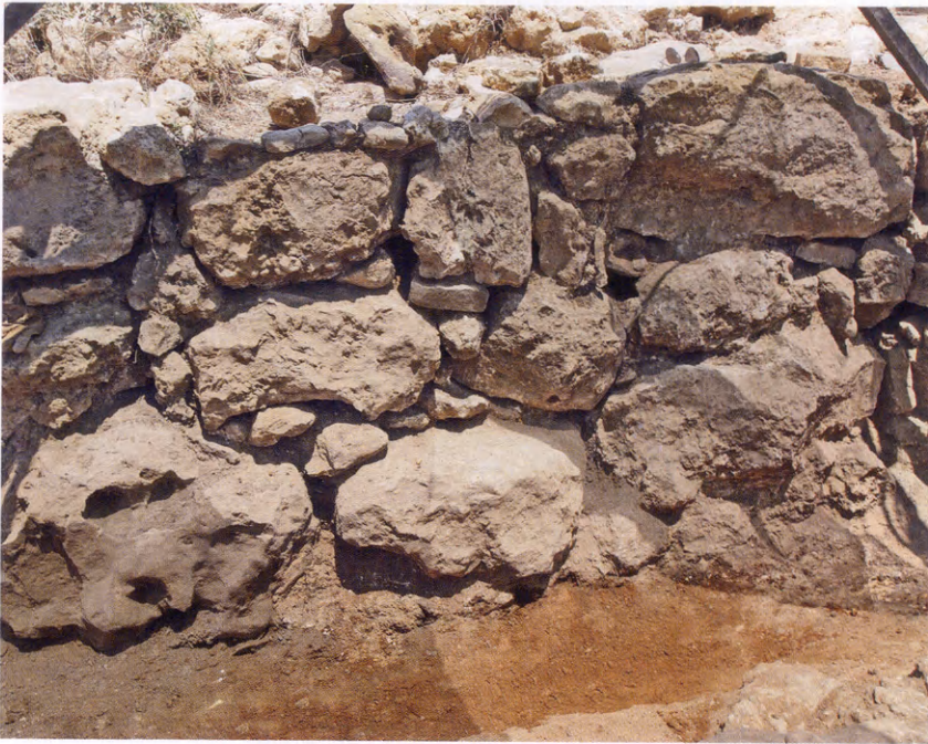
9 Ίκλαινα Μεσσηνίας. Ἡ νότια πρόσοψη τοῦ κυκλωπέιου ἀνδῆρου ἀπὸ Ν.
