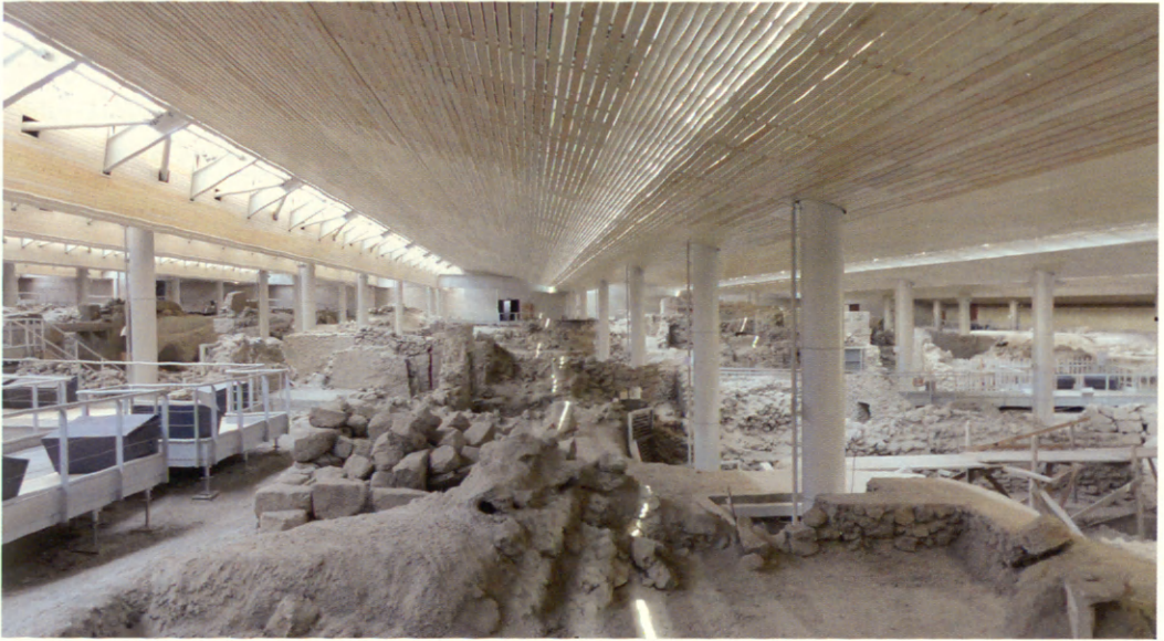
26 Άκρωτήρι Θήρας. Γενική άποψη του οικισμού με τὸ νέο στέγαστρο.
