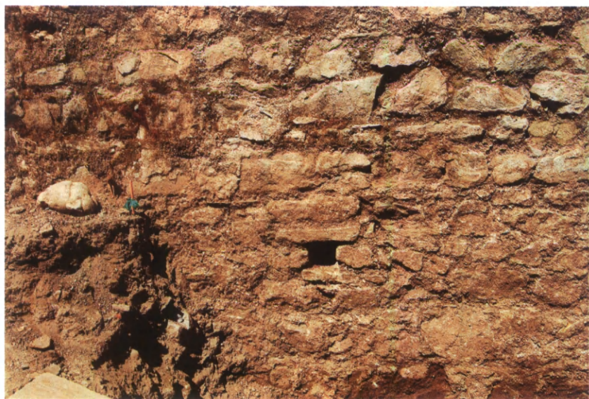
62 Λεπτομέρεια εσωτερικού τοιχώματος υπόγειας δεξαμενής.
