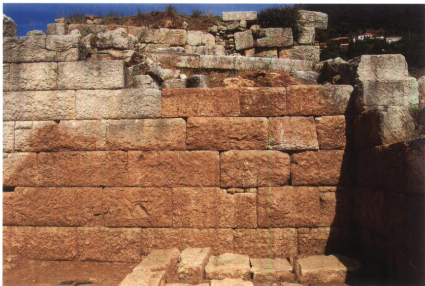
53 Λεπτομέρεια τοῦ ἀνατολικοῦ ἀναλήμματος.
