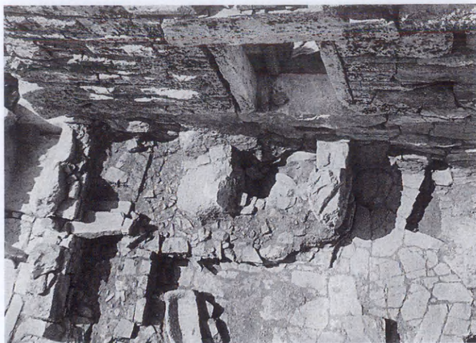
62 Ὁ χώρος πρόσβασης στὸν κυρίως πύργο: διακρίνονται ἡ κτιστὴ κατασκευὴ-ὑπόβαθρο κλίμακος καὶ ἡ λάρναξ (2006).
