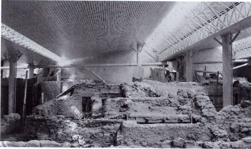
67 Βόρειος τομέας μετὸ στέγαστρο δλοκληρωμένο.
