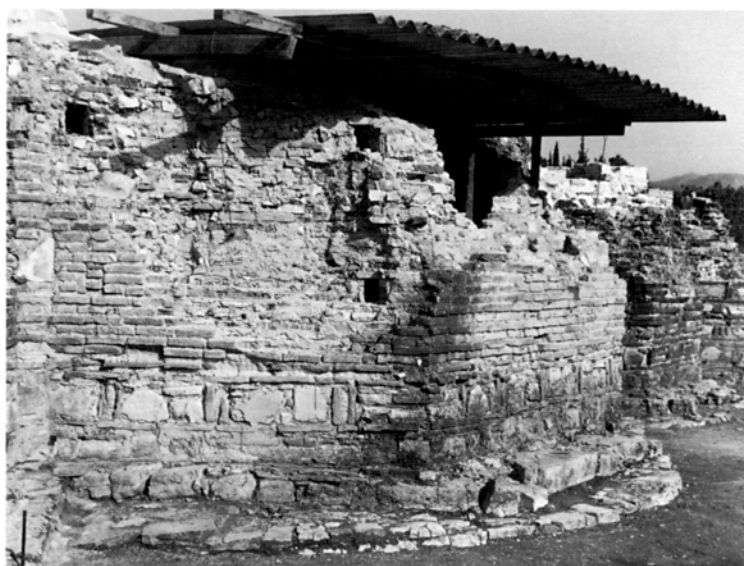
24 Ἡ τρίπλευρη κεντρικὴ ἀψίδα μετὰ τὴν ἀποκάλυψη τῆς καμπύλης υποθεμελιώσεως.
