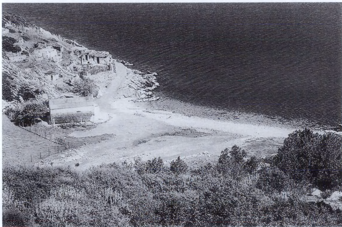
1 Τὸ ἐπιχωσμένο ἀπὸ τὸ ρέμα Τσόναλι δυτικὸ λιμάνι τοῦ φρουρίου μὲ τὴν ἐκκλησία τῆς Ἁγίας Μαρίας.
