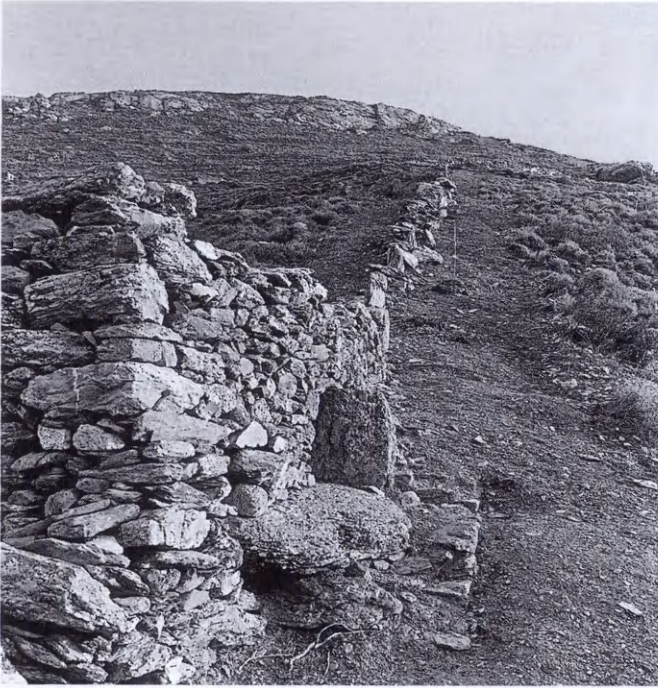
94 Μερική άποψη τῆς “πυλίδας” τοῦ δυτικῶ τοίχου.
