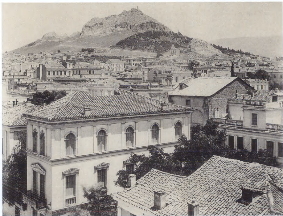
Ὁψη τμήματος τῆς Ἀθήνας τῆς πρώτης δεκαετίας τοῦ αἰῶνα. Στὸ βάθος ψηλά ὁ Λυκαβηττός καὶ τὰ λατομεῖα του.
