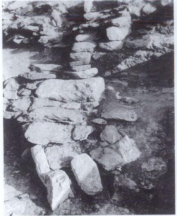
63 Ὁ πλακοσκεπῆς ἀγωγὸς καὶ ὁ φυσικὸς βράχος μετὰ ἀπὸ τῆ συντήρηση.
