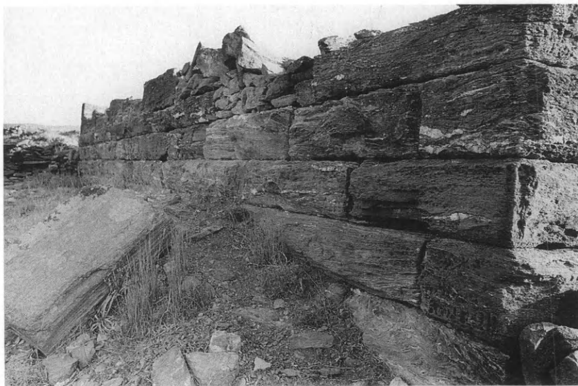
44 Τὸ Κτίριο 1, ἀπὸ Νότο.
