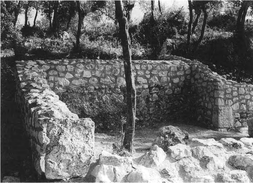
7 Ὁ χώρος Ρ τῆς σκανᾶς μετὰ τὴ συντήρηση.
