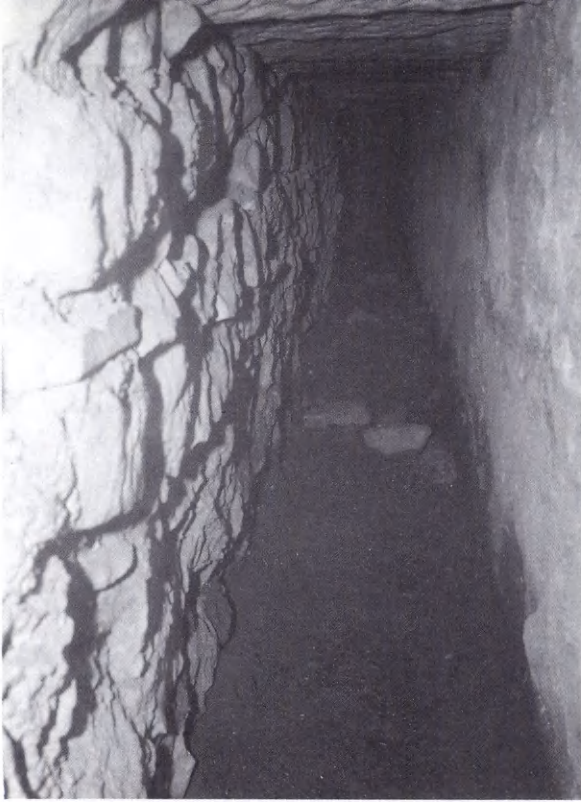
11 Ὁ ἀγωγὸς μέσα στὸ θεμέλιο τῆς πρόσοψης τῆς Σκανᾶς μετὰ τὸν καθαρισμό.
