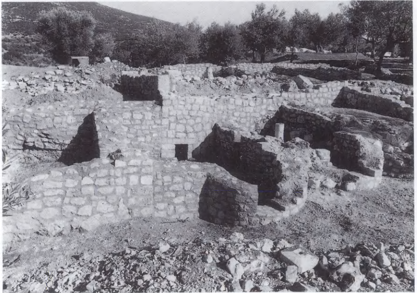
22 Τὸ κτίριο τῶν λουτρῶν μετὰ τὶς ἐργασίες ἀποκατάστασης.
