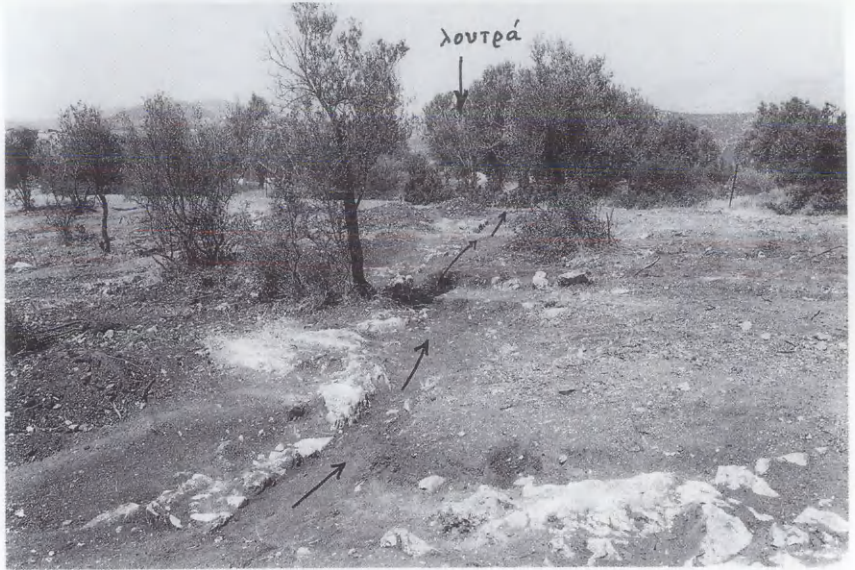
21 Ἐπίγειος ἀγωγὸς στὴ νοτιοανατολικὴ πλαγιά τοῦ Κυνορτίου (μακριὰ ἀπὸ τὴ δεξιαμενὴ).
