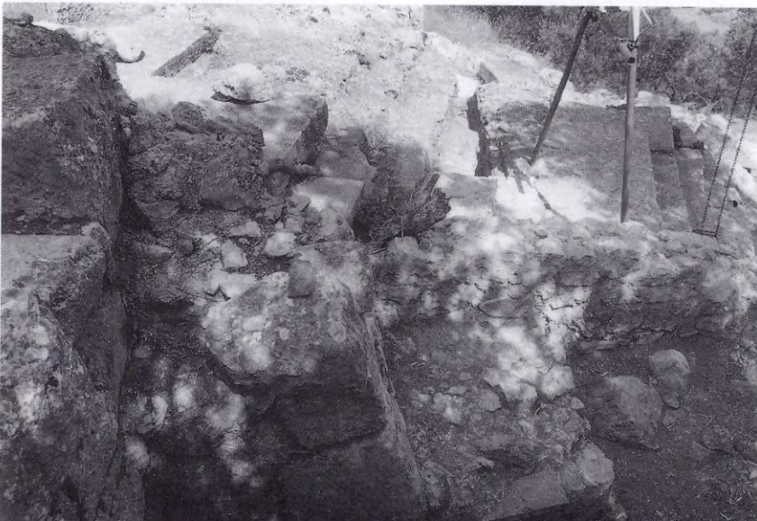
15 Τὸ προστατευτικὸ κάλυμμα τῶν καταρρακτῶν πρὸς τὸ ὑπόγειο ὑδραγωγεῖο καὶ κάτω δεξιὰ τὸ στόμιο τοῦ ὀχετοῦ.
