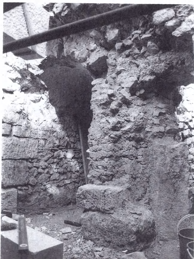
13 Ἡ ἀπόληξη τοῦ θολωτοῦ διαδρόμου πρὸς τὸ λουτρὸ πρὶν ἀπὸ τὶς ἐργασίες.
