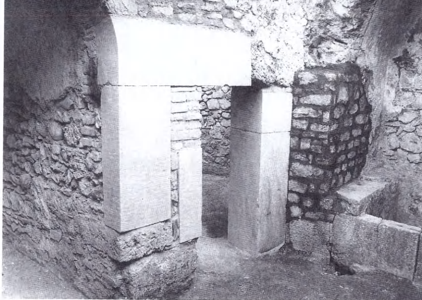
12 Ἡ θύρα πρὸς τὸν κυκλικὸ χῶρο Π ἀποκατεστημένη.
