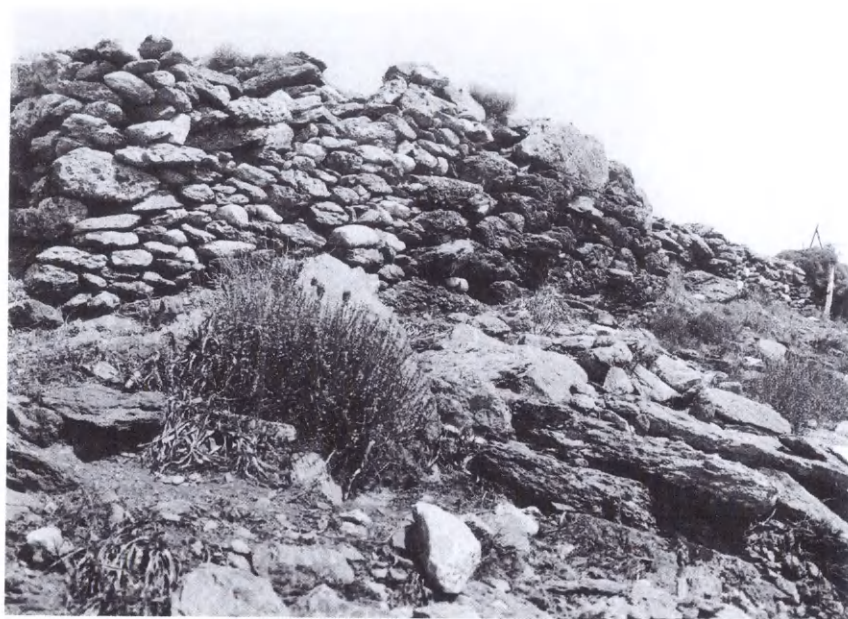
159 Τμήμα του γεωμετρικού τείχους στην Κάτω πόλη.
