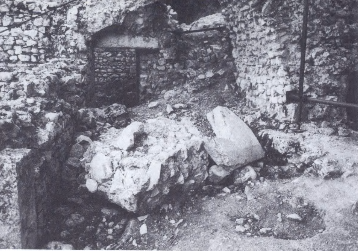
17 Ἡ εἴσοδος τοῦ λουτροῦ πρὶν ἀπὸ τὶς ἐργασίες.
