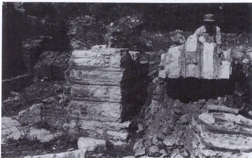
98 Πεσσός τῆς βόρειας πλευρᾶς πρὶν τὴν ἀναστήλωσή του.
