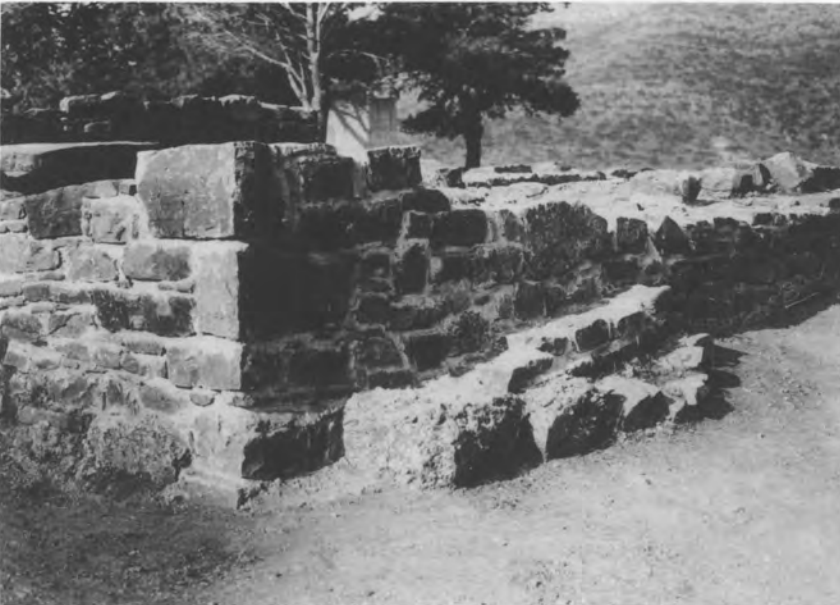
41 Ὁ βορειοανατολικὸς τοῖχος τῆς παλαιοχριστιανικῆς βασιλικῆς μετὰ τὶς στερεωτικὲς ἐργασίες.
