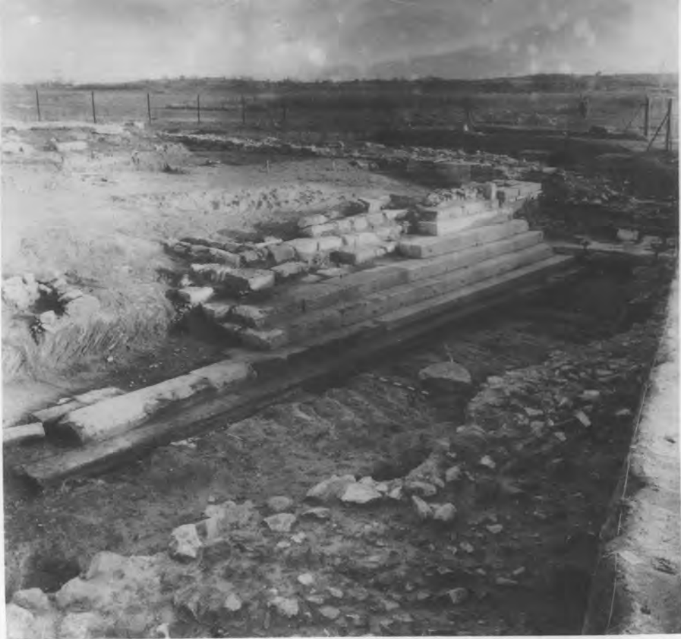
94 Βόρειος περίβολος. Ἱερό ἐκτὸς τειχῶν. Ἀποψη τῆς κλίμακας ἀπὸ ΒΔ.
