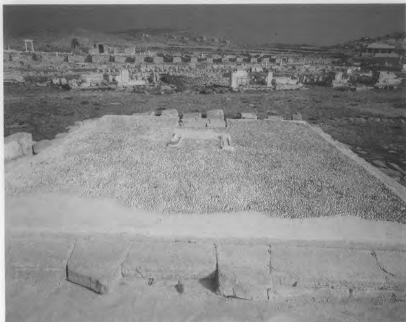
154 Μαρμάρινο δάπεδο Προπυλαίων μετά τη συντήρηση.
