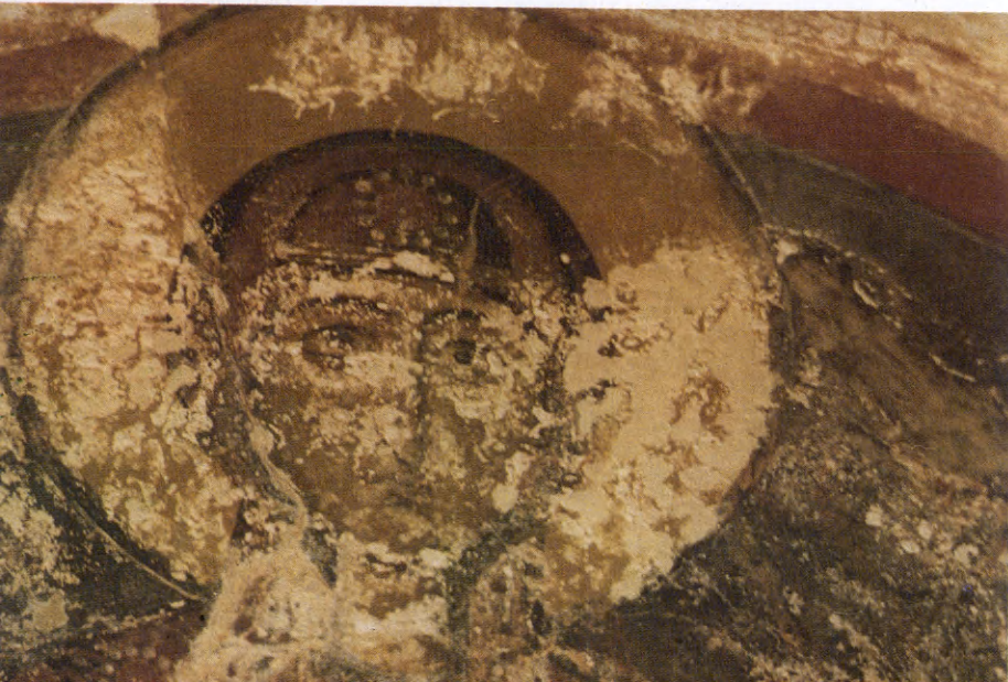
Εικ. 116. Ἡ τοιχογραφία τῆς Πλατυτέρας πρὶν καὶ μετὰ τὶς φθορὰς ἀπὸ τὴν ὑγρασία.
