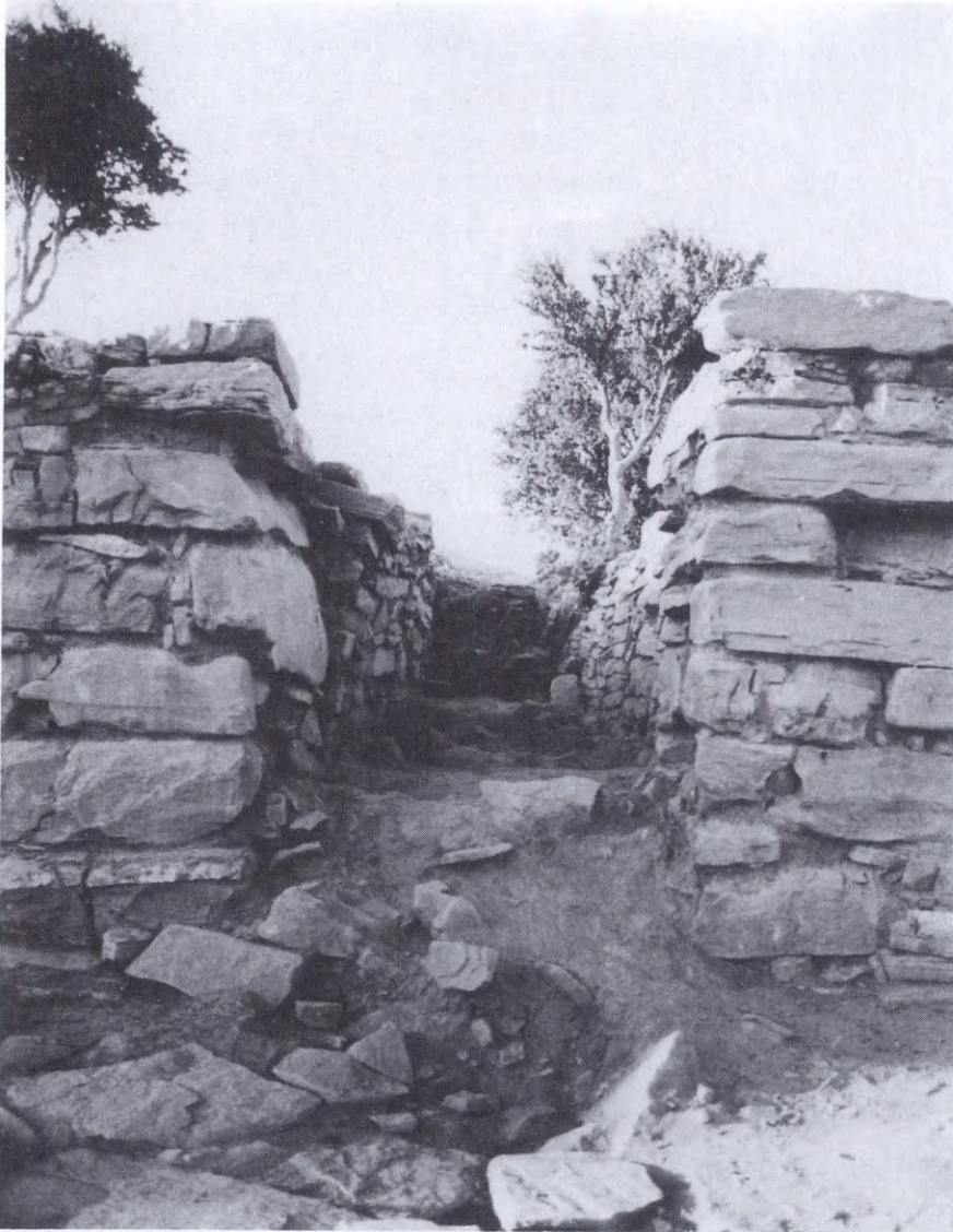
Εἰκ. 135. Ἡ βόρεια εἴσοδος τοῦ κεντρικοῦ κτιρίου.
