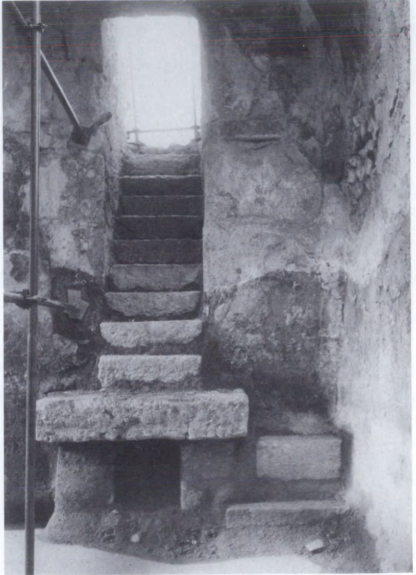
Εικ. 20. Ἡ κλίμακα καθόδου τῆς δεξαμενῆς καὶ τὸ στόμιο ἀποροῆς τοῦ νεροῦ.
