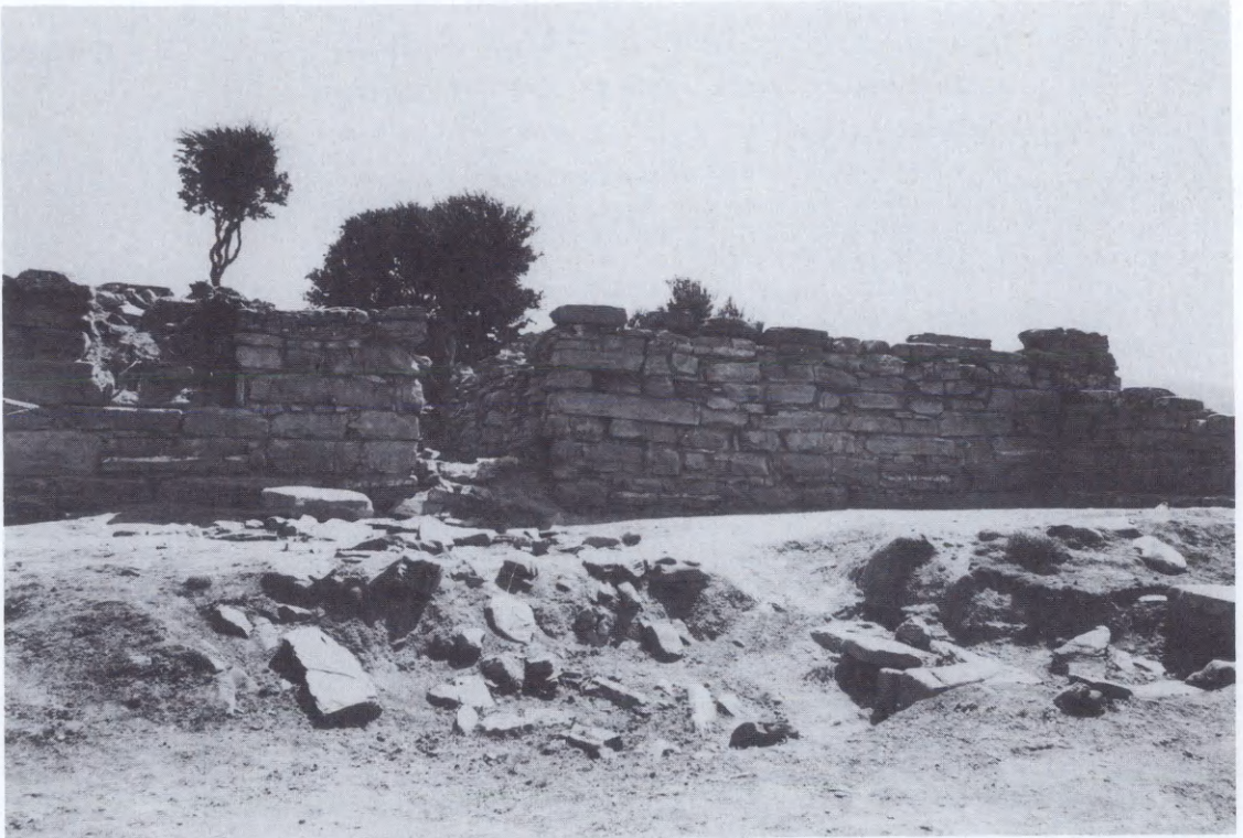
Εἰκ. 134. Ἀποψη τμήματος τοῦ κεντρικοῦ κτιρίου.
