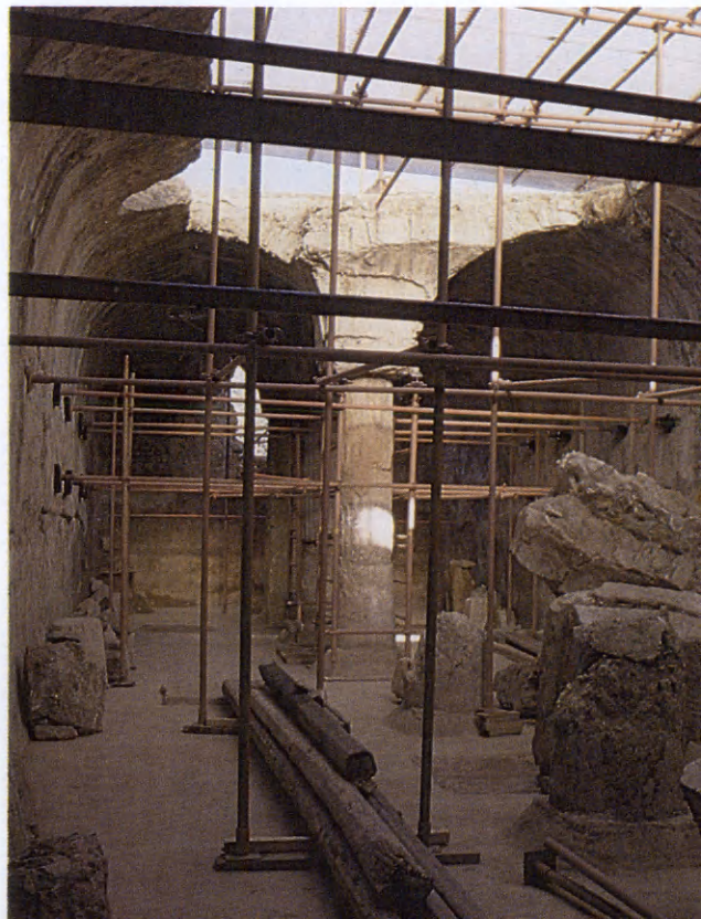
Είχ. 19. Τὸ ἐσωτερικὸ τῆς δεξαμενῆς ἀπὸ τὰ νότια μετὰ τὸν καθαρισμό.
