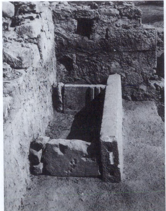
Εἰκ. 83. Ἐξωτερικὸς δυτικὸς περίβολος. Πύργος Α. Τάφος στὸ ἐσωτερικὸ τοῦ πύργου.
