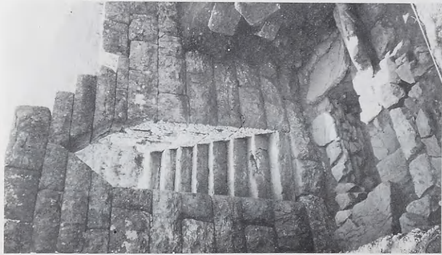
119-120. Μεσσήνη: 119. Δυτικό ανάλημμα θεάτρου. Όξυκόρυφη πύλη με κλιμακωστά ανοόδου προς τὸ διάζωμα. 120. Ἡ τρίτη νοτιότερη ὀξυκόρυφη πύλη τοῦ δυτικοῦ ἀναλήμματος τοῦ θεάτρου, πρὶν τὴ στερέωση.
