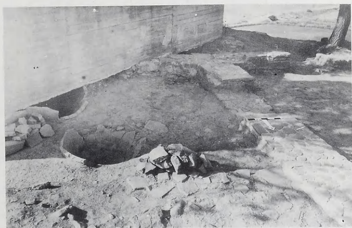
84-85. Κάτω Βασιλική Αιτωλίας: 84. Ἡ πύλη 1. 85. Ἡ τσιμεντένια δεξαμενή πάνω στὸν ἀποθηκευτικὸ χῶρο.
