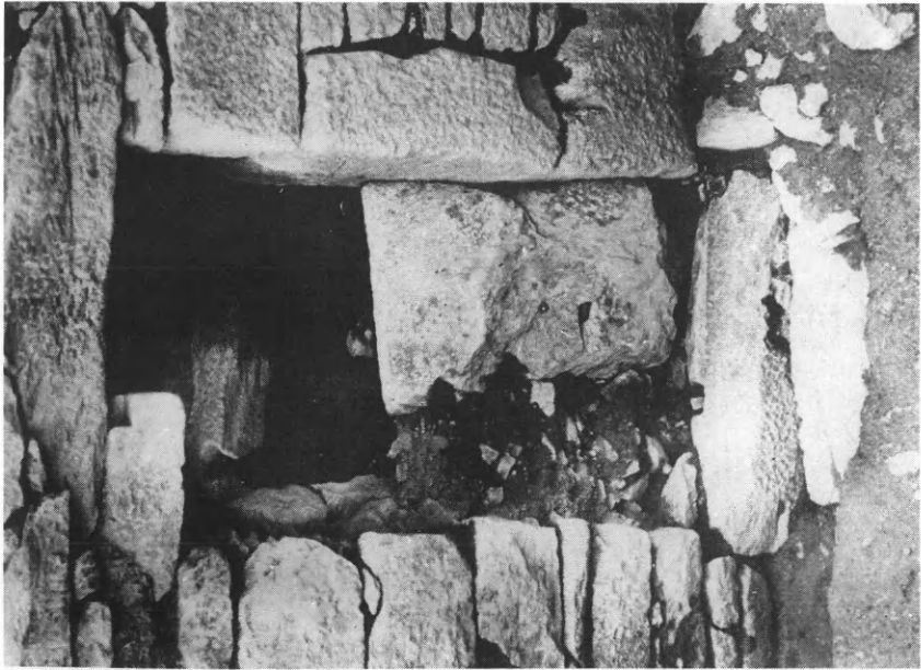
99. Μινώα Ἀμοργοῦ. Ἀπογορητήριο. Θύρα με παραστάδες και κατάφλι.
