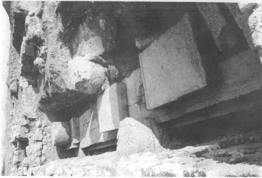
39. Πέλλα. Ἀνάκτορα. ΒΑ. γωνία ἀτέλειωτου στῳικοῦ οἰκοδομήματος, ἀπὸ Ν.
