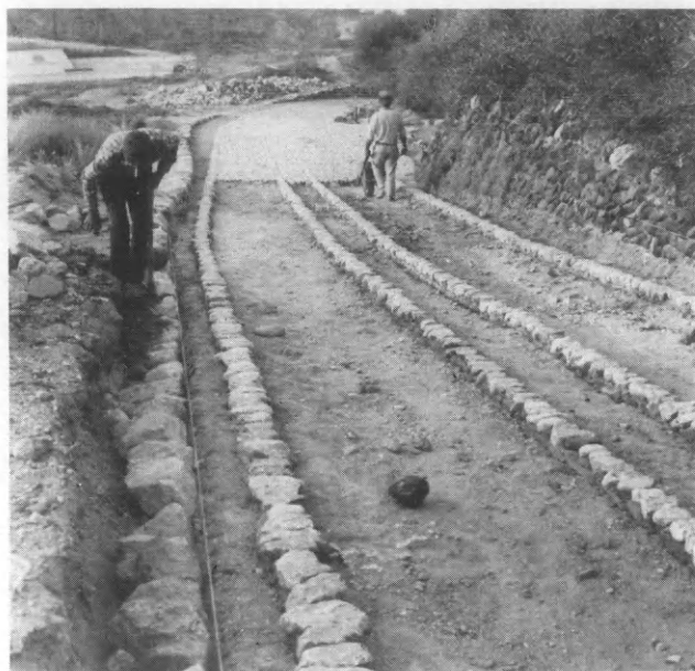
92. Θήρα. Ἡ λιθόστρωση τμήματος τῶν προσβάσεων πρὸς τὴν ἀνασκαφή.
