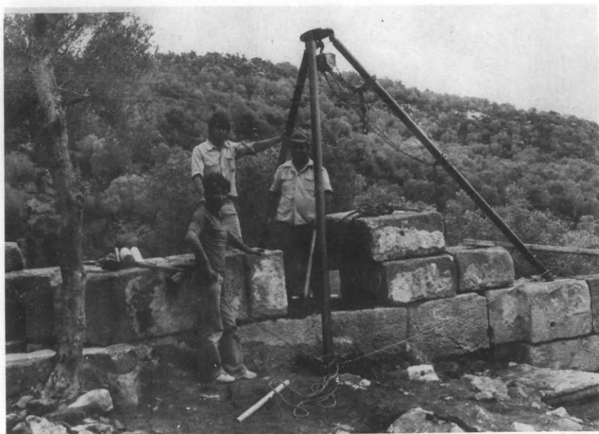
5. Σύναξη Μαρωνείας. Στερέωση και καθαρισμός τῶν δόμων τοῦ νοτίου περυγίου τῆς βασιλικῆς.
