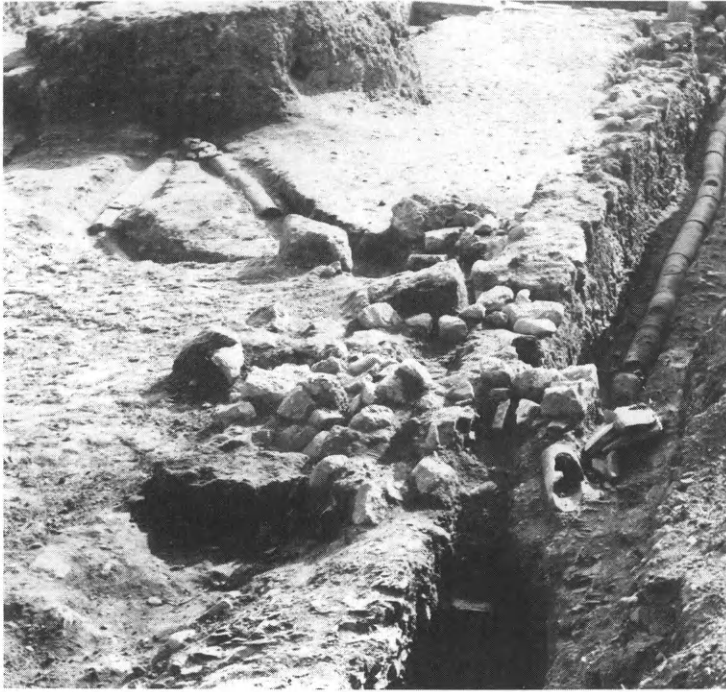
18. Ἀμφίπολη. Τμήμα τοῦ πήλινου ἀγωγοῦ με δύο διακλαδώσεις του.
