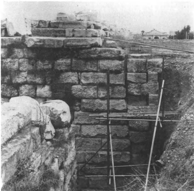
71. Ἐλευσίς. Νότιο ἄνδρo τῆς Φιλωνείου Στοᾶς. Ὑποστύλωση τῶν ἀκραίων ποροπλίνθων.
