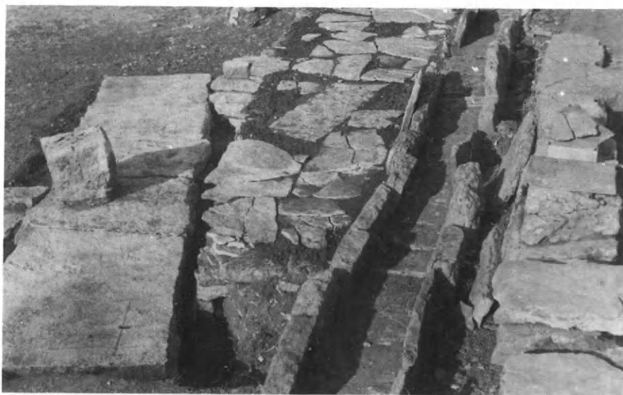
48. Δωδώνη. Ἀποχευτικός ἀγωγός καὶ πλακόστρωτον.
