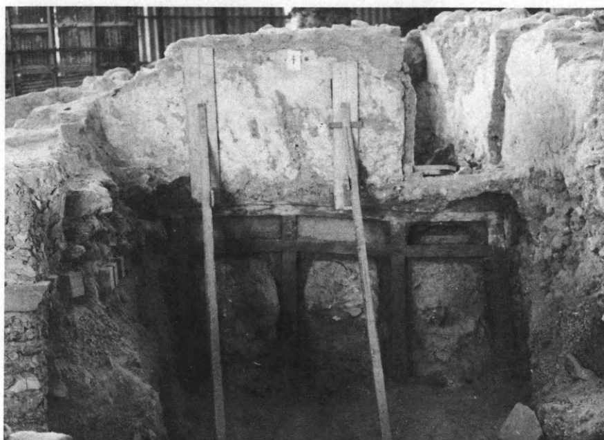
85. Θήρα. Συμπλήρωσις ξυλίνων πλαισίων πολυθύρου με όπλισμένον σκυρόδεμα.
