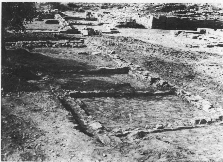
3. Μεσημβρία. Τὰ ἀποκαλυφθέντα θεμέλια κτισμάτων.
