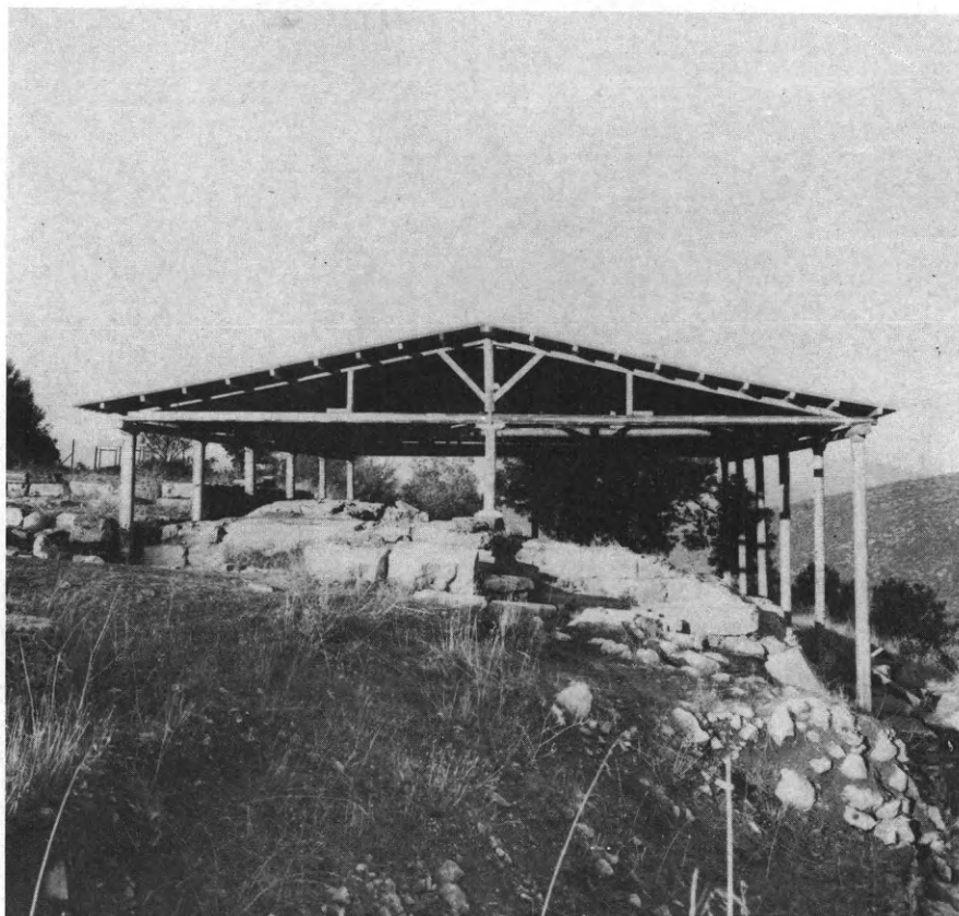
54. Ἐπίδαυρος. Τὸ κατασκευασθὲν προστατευτικὸν στέγαστρον.
