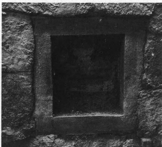
86. Θήρα. Συμπλήρωσις ξυλίνου πλαισίου παραθύρου με όπλισμένον σκυρόδεμα.
