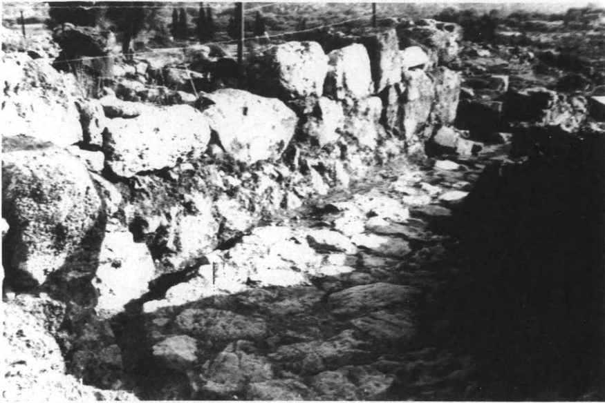
94. Ζάκρος. Λιθόστρωτος δρόμος μεταξύ τῶν κτιρίων Β καὶ Γ ἀπὸ ΒΔ.
