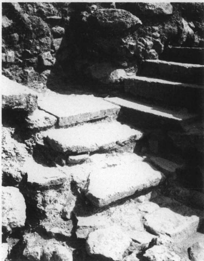
90. Ζάκρος. Ἡ κλίμαξ μετὰ τὴν ἀποκατάστασιν ἀπὸ ΝΔ.
