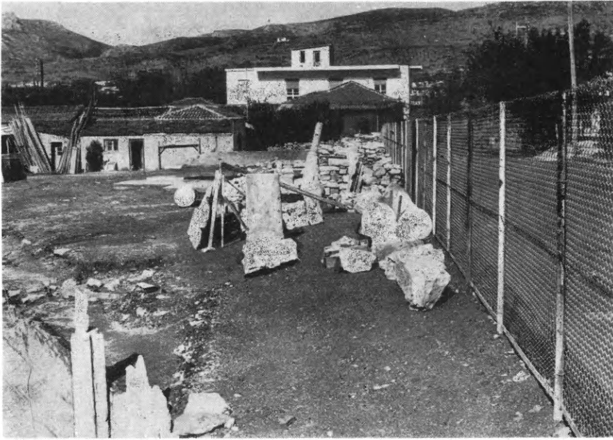
Εικ. 180. Ν. Ἀγχιάλος. Ὁ χώρος Β. τῆς βασιλικῆς μετὰ τὴν κατεδάφισιν τῆς οἰκίας Τζοτζόλα.
