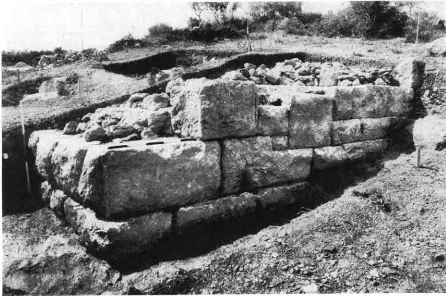
Εἰκ. 64. Τορώνη. Ἡ προεξέχουσα γωνία 1 εἰς τὸ τμήμα Ο τοῦ τείχους, ἀνατολικῶς τῆς πύλης.
