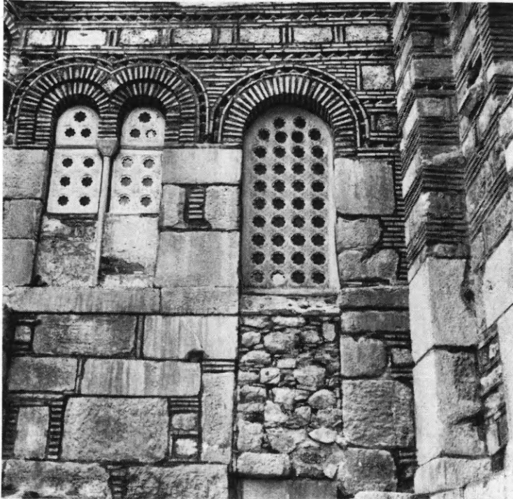
Εἰκ. 114. Ὁσῖος Λουκάς. Ἡ πεφραγμένη ἀνατολική θύρα τοῦ ΒΑ. παρεκκλησίου τοῦ καθολικοῦ. Κάτω διακρίνεται τὸ μαρμάρινον αὐτῆς κατώφλιον.
