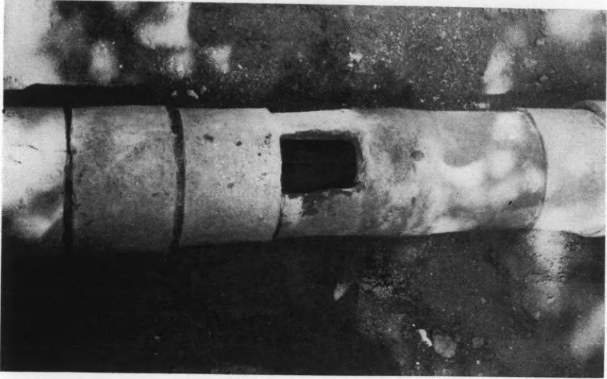
Εἰκ. 16. Ἐρέτρια. Λεπτομέρεια ἀγωγοῦ ὕδρευσεως. Διακρίνονται τὰ ἀνοίγματα καθαρισμοῦ.
