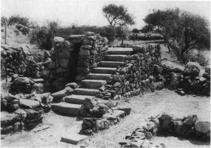
Εἰκ. 107. Ἡ κλιμαξ τοῦ κτηρίου Η μετὰ τὴν ἀποκατάστασιν τῆς, ἐκ Δ.
