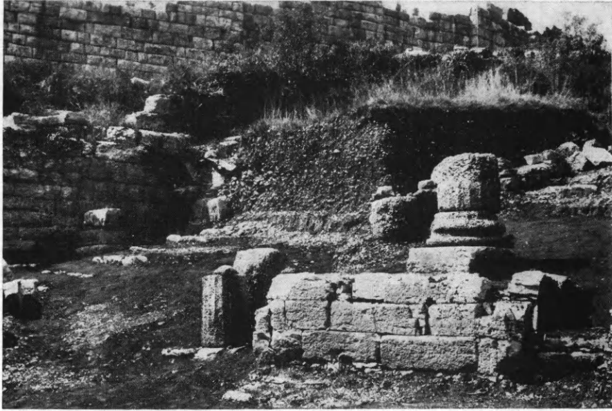
Εἰκ. 150. Ἀποψὶς ἐκ Νότου τῆς δυτικῆς πλευρᾶς τοῦ βουλευτηρίου.
