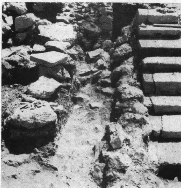
Εἰκ. 278. Ἡ κλιμαξ Μ τοῦ κτηρίου Η κατὰ τὴν ἐργασίαν ἀποκαταστάσεως.
