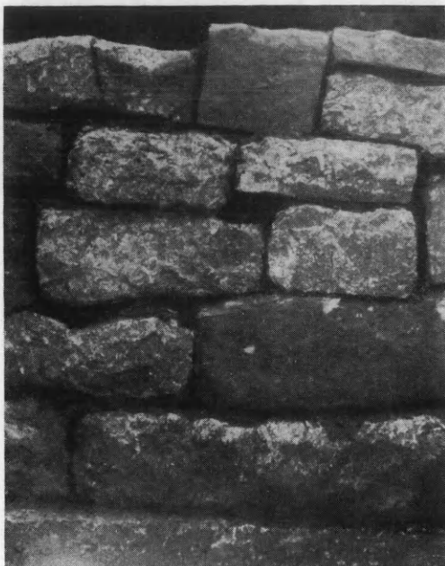
Εικ. 92. Τμήμα τοίχου έλληνιστικής οικοδομής άποκαλυφθέν έντός τής τάφρου Γ.
