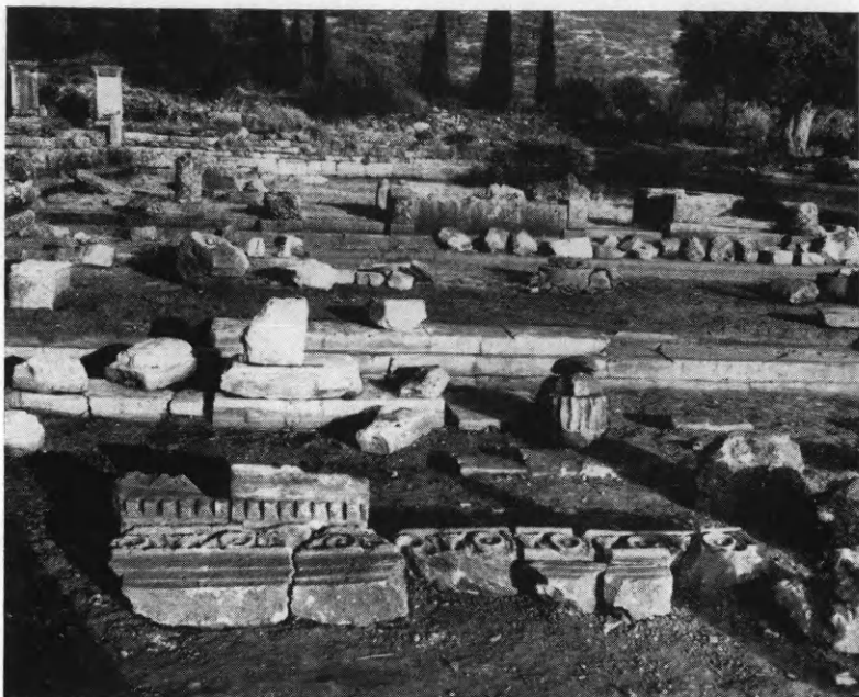
Εικ. 182. Πώρινα μέλη του θριγκού των στοών (ζωφόρος και γείσον).
