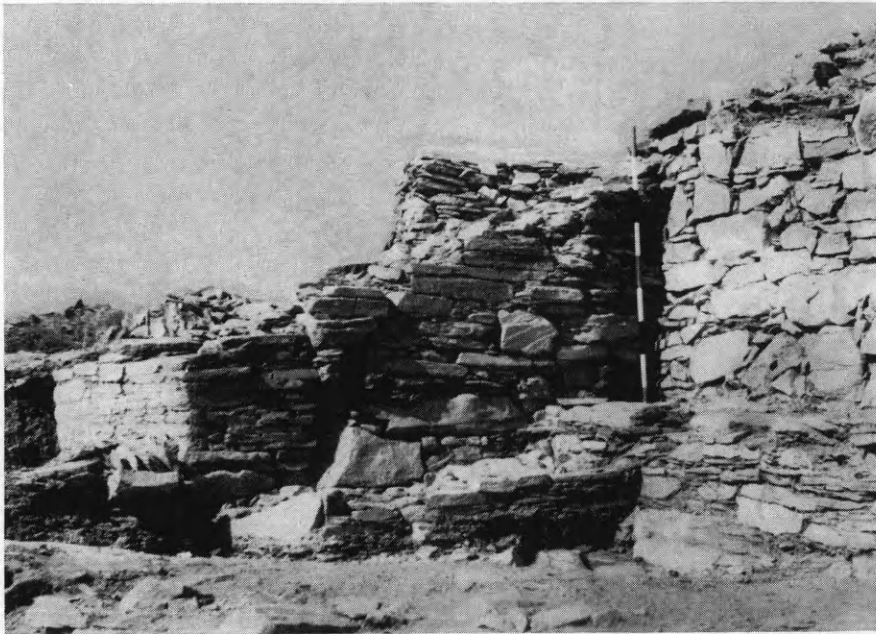
Εἰκ. 169. Ἡ πύλη τοῦ τείχους τοῦ συνοικισμού τῆς Ζαγοράς πλησίον τοῦ νοτίου τέρματος αὐτοῦ. Διακρίνονται ὁ βόρειος πυλὼν καὶ ὁ προμαχῶν πλησίον αὐτοῦ. Ἀποψις ἀπὸ Ἀνατολῶν.
