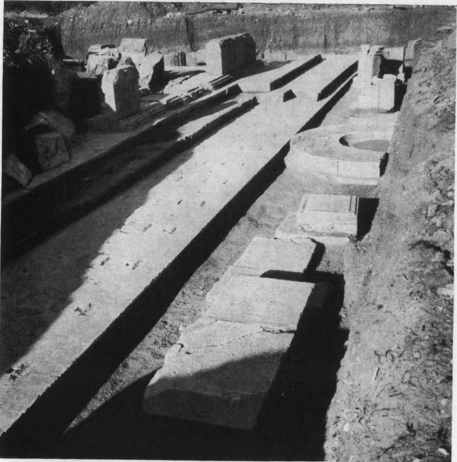
Εἰκ. 241. Ἀποψὶς τῆς κρηπίδος τοῦ ναοῦ μετὰ τοῦ ἀναστηλωθέντος κυματιοφόρου τοιχοβάτου καὶ τῶν ἐπ' αὐτοῦ ὀρθοστατῶν τοῦ σηκοῦ.
