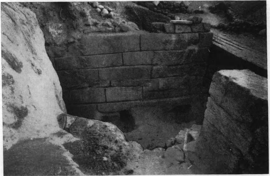
Εικ. 191. Ἀνακτορικὸν κτίσμα. Παράθυρα τοῦ ἰσογείου (κάτω).
