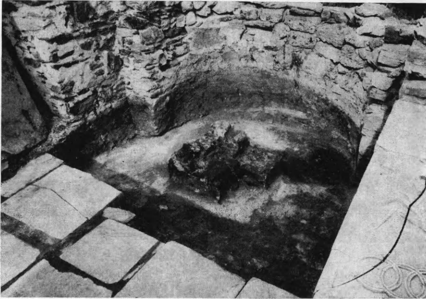
Εἰκ. 34. Ἡ Α. πλευρὰ τοῦ διακονικοῦ τῆς βασιλικῆς τοῦ Ἁγίου Ἀχιλλεῖου μετὰ τὴν ἀνασκαφὴν.
