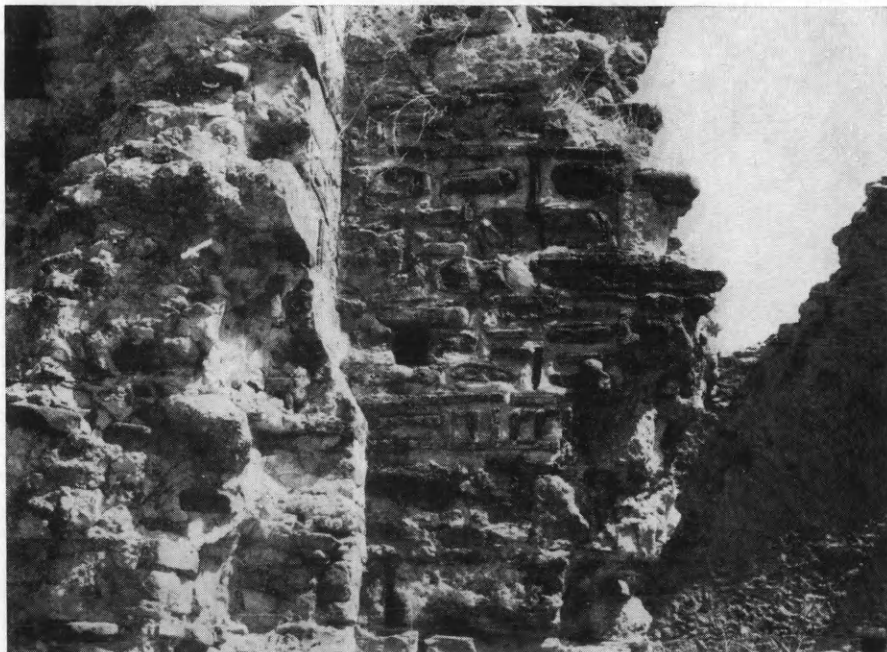
Είχ. 106. «Άγιο-Λέος». Τοιχοδομία με κεραμοπλαστικά. Νοτία ὄψις ἀριστερὰ τοῦ νοτίου ἀνοίγματος.
