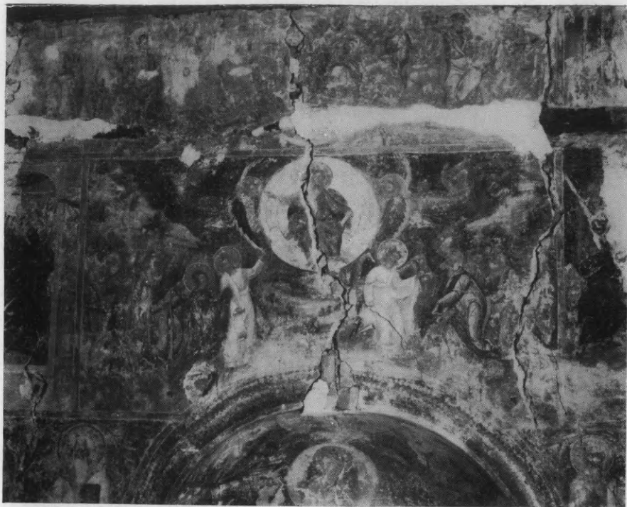
Είκ. 17. Λευκάς, ἐκκλησία Ὁδηγητρίας. Τοιχογραφία τοῦ ἀνατολικοῦ τοίχου.
