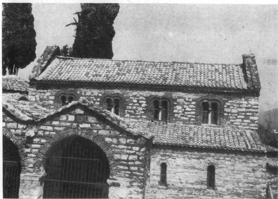
Είκ. 142. Ἡ νέα κατασκευασθεῖσα στέγη τῆς Ἀγ. Θεοδώρας.
