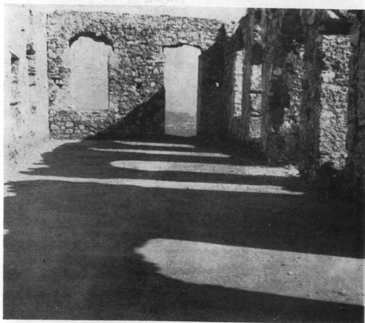
Εἰκ. 164. Σπίτι Φραγκοπούλου μετὰ τὰς ἐργασίας.
