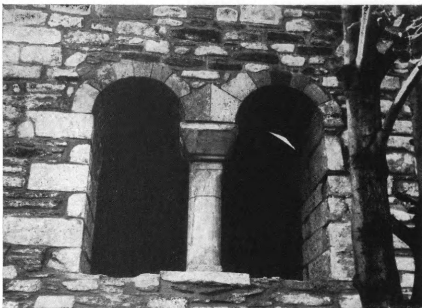
Είκ. 158. Τὸ ἀνοιχθὲν κατὰ τὴν βόρειον πλευρὰν τοῦ Ἁγ. Νικολάου δίλοβον παράθυρον μετὰ τὰς ἐργασίας ἀποκαταστάσεως αὐτοῦ. (Φωτογρ. Χ. Σφακιανᾶκη)
