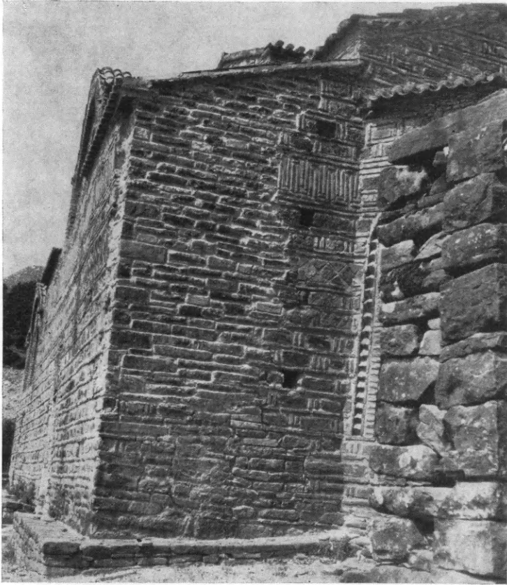
Εἰκ. 132. Ἡ ΝΑ. γωνία τῆς Κόκκινης Ἐκκλησιᾶς μετὰ τὰς ἐργασίας ἀναστηλώσεως αὐτῆς.
