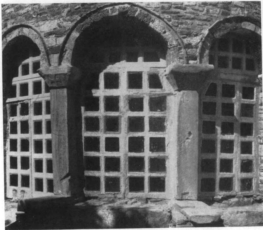
Εἰκ. 217. Οἱ ἀποκατασταθέντες μαρμαρίνοι φεγγῖται τοῦ τριλόβου παραθύρου τοῦ ἱεροῦ τῆς Καταπολιανῆς.
