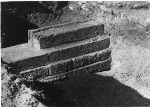
Εἰκ. 60. Κρηπίδωμα οἰκοδομῆς ἐσωτερικῶς τῆς δυτικῆς πύλης.
