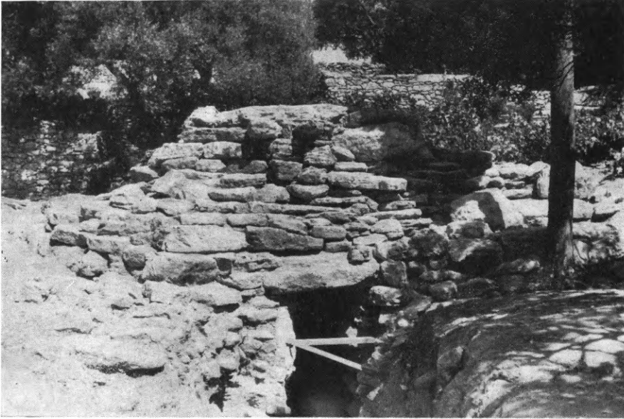
Εἰκ. 224. Ὁ θολωτὸς τάφος Α μετὰ τὰς ἐργασίας ἀποκαταστάσεως αὐτοῦ.
