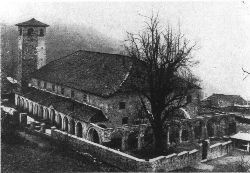
Εἰκ. 201. Ὁ ναὸς τοῦ Ἁγ. Γεωργίου Νεγάδων ἀπὸ ΒΔ. μετὰ τὴν ἀποκατάστασιν τῆς ἐξωτερικῆς δυτικῆς κιονοστοιχίας.
