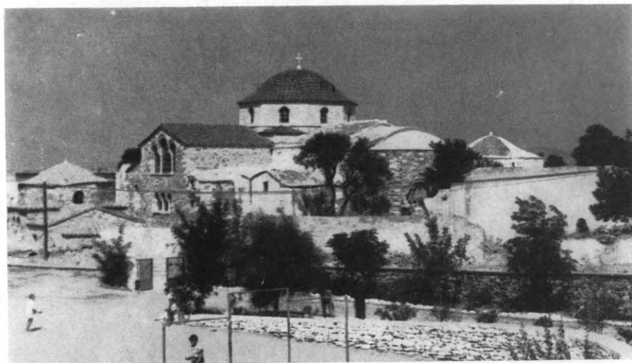
Εικ. 220. Ὁπίσθεν τοῦ συγκροτήματος τῆς Καταπολιανῆς μετὰ τὴν ἀπομάκρυνσιν τοῦ βουνοῦ τῶν ἀπορριμμάτων τῆς ἀναστηλώσεως.
