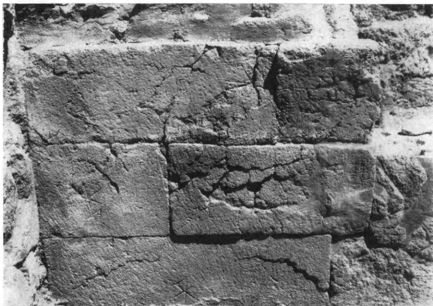
Είκ. 167. Ἀνάκτορον Ζάκρου. Τοίχος ἐξ ἄρμωστῶν πελεκητῶν πωρολίθων μὲ πέντε σύμβολα διπλῶν πελέκεων.
