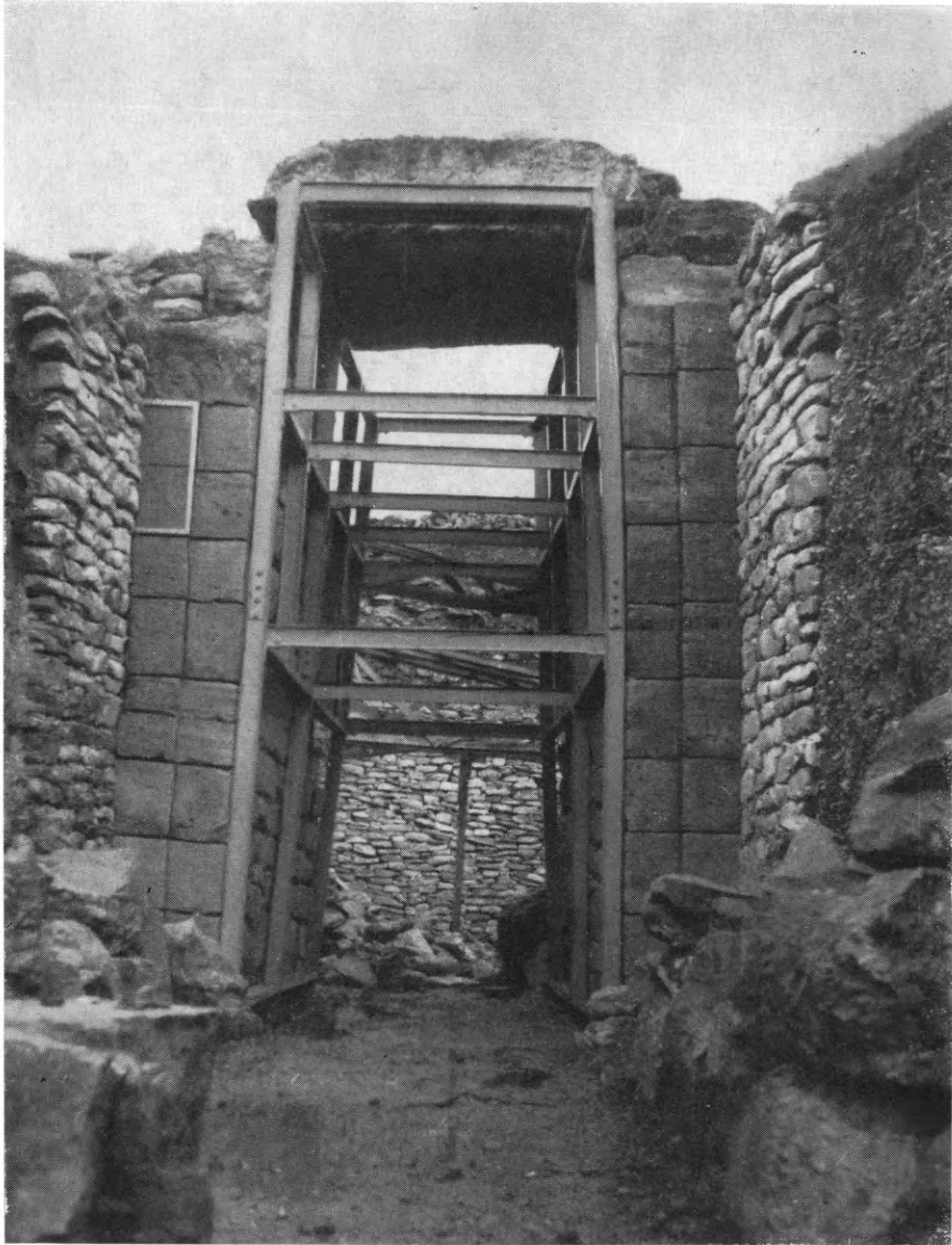
Εἰκ. 173. Ἡ θύρα εἰσόδου τοῦ τάφου 1 τῆς Περιστεριάς μετὰ τοῦ σιδηροῦ της πλαisiou στηρίξεως.
