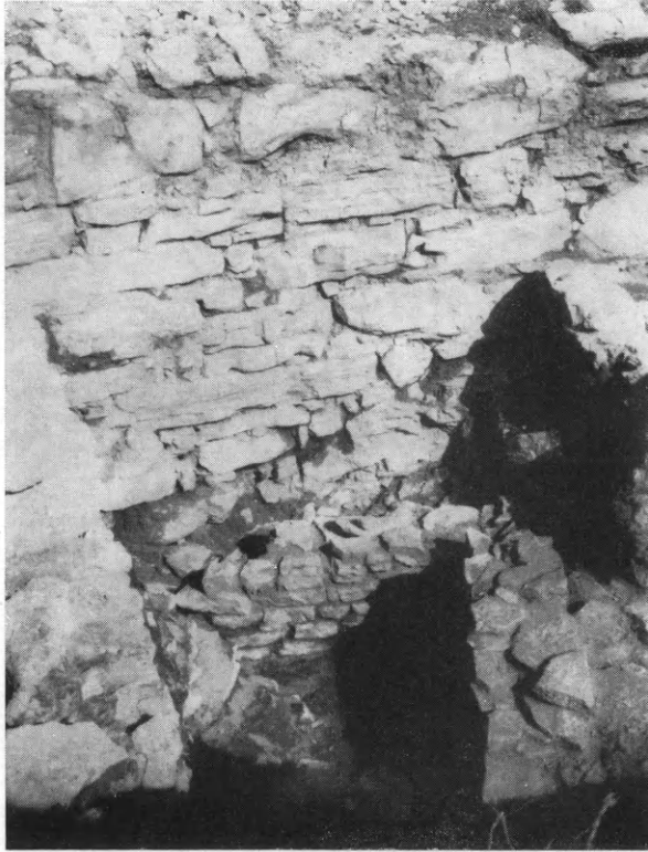
Εἰκ. 123. Τμήματ' αὐτῶν τοίχων τοῦ ἐκ δύο δωματίων ΠΕ οἰκοδομήματος εἰς τὸν τομέα παρὰ τὴν Μέσην πύλην.
