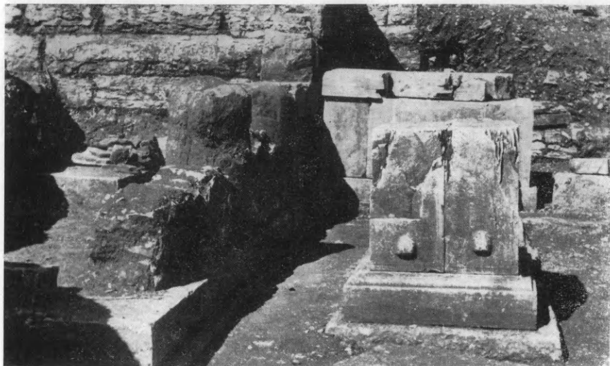
Εἰκ. 64. Ὁ ἀνατολικὸς στυλοβάτης τῆς πρὸ τοῦ Βουλευτηρίου συνεχόμενης στοᾶς μετὰ τῶν βάθρων 5 καὶ 2.
