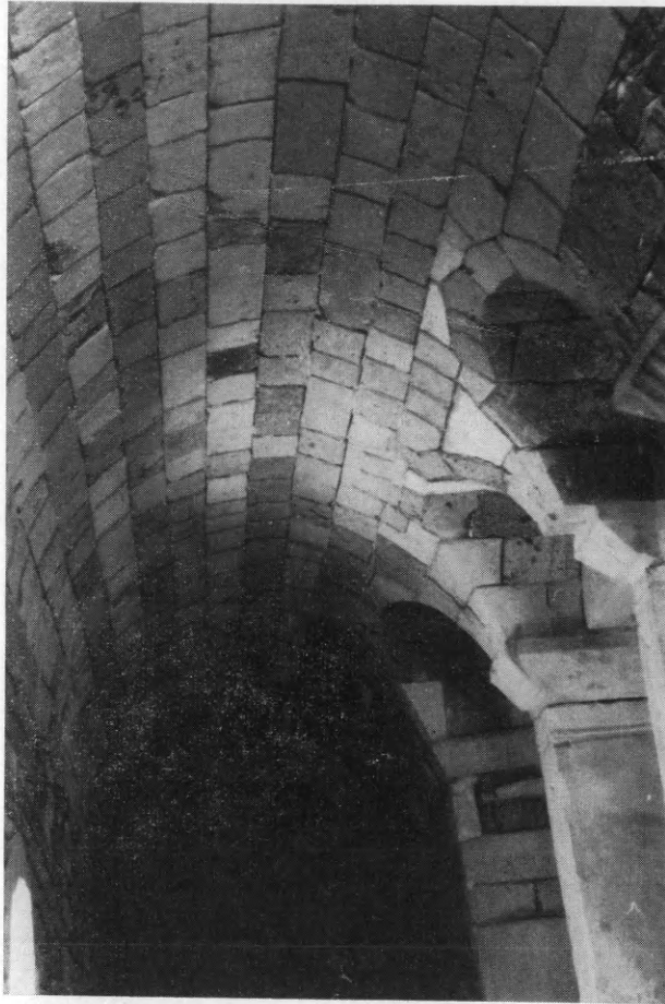
Εἰκ. 191. Ὁ ἀναστηλωθεὶς κυλινδρικός θόλος τοῦ νοτίου κλίτους τοῦ βαπτιστηρίου τῆς Καταπολιανῆς Πάρου.
