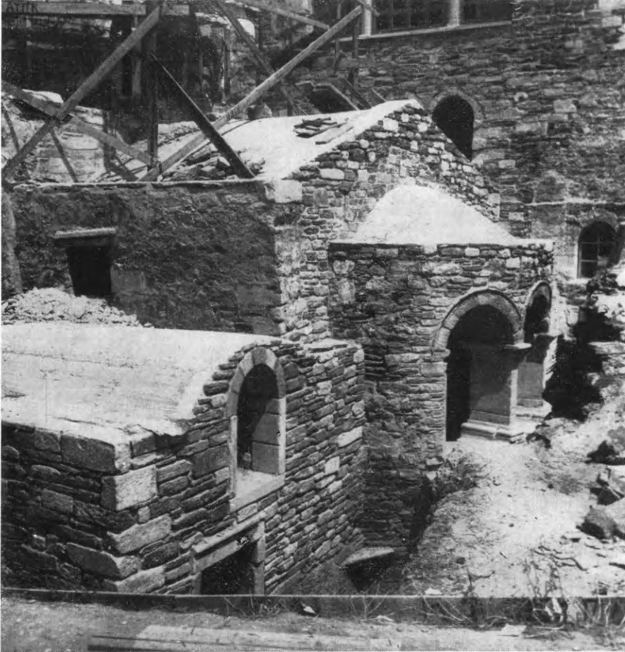
Εἰκ. 190. Οἱ θόλοι τοῦ βαπτιστηρίου τῆς Πάρου μετὰ τὴν στερέωσιν αὐτῶν καὶ πρὸ τῆς ἐπιπεραμώσεώς των.
