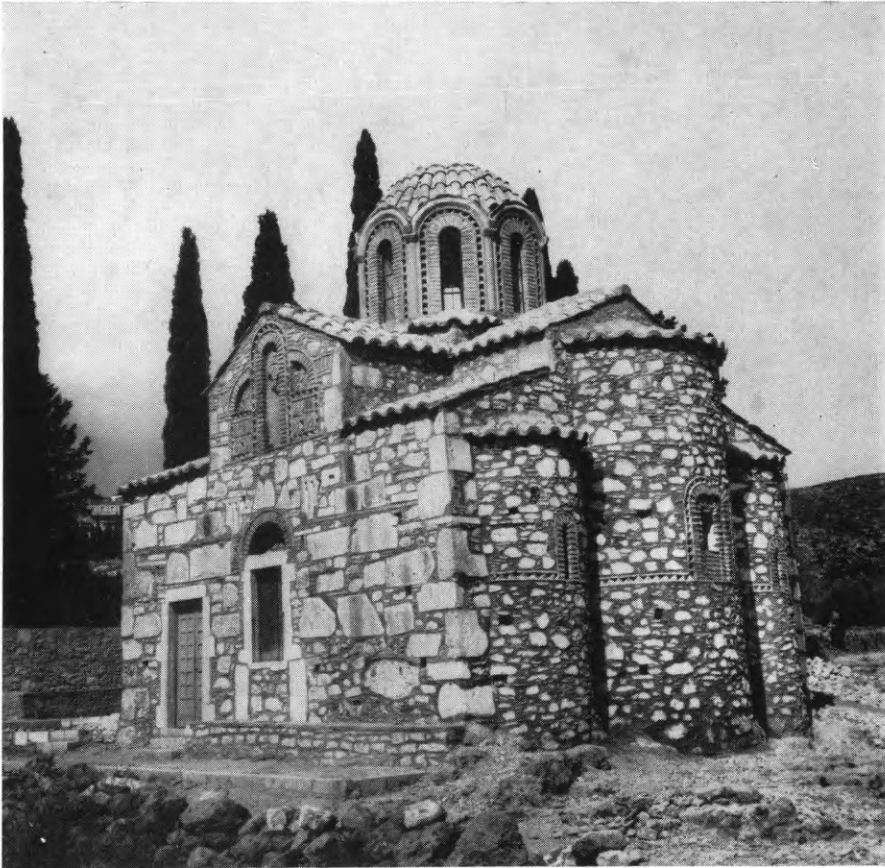
Εἰκ. 200. Ὁ ναὸς τοῦ Ἁγ. Ἀθανασίου εἰς Γεράκι μετὰ τὴν ἀφαίρεσιν τῶν μεταγενεστέρων κονιαμάτων τοῦ ἱεροῦ.
