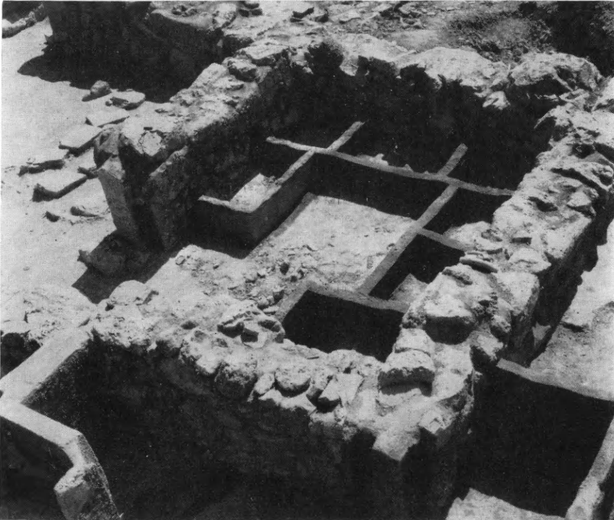
Εἰκ. 169. Τὸ θησαυροφυλάκιον τοῦ Ἱεροῦ τοῦ Ἀνακτόρου Ζάκου μετὰ τὴν στερέωσιν καὶ ἀποκατάστασιν τῶν θηκῶν.
