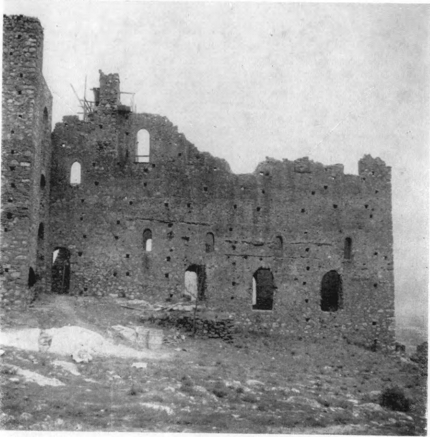
Εἰκ. 201. Ἡ Νοτία πλευρὰ τοῦ ἀνακτόρου τῶν Καντακουζηνῶν εἰς τὸν Μυστράν, πρὸ τῶν ἐργασιῶν τοῦ 1964.
