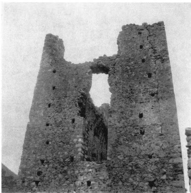
Εἰκ. 203. Ἡ Ἀνατολικὴ πλευρὰ τοῦ ἀνακτόρου τῶν Καντακουζηνῶν εἰς Μυστρᾶν, πρὸ τῶν ἐργασιῶν τοῦ 1964.
