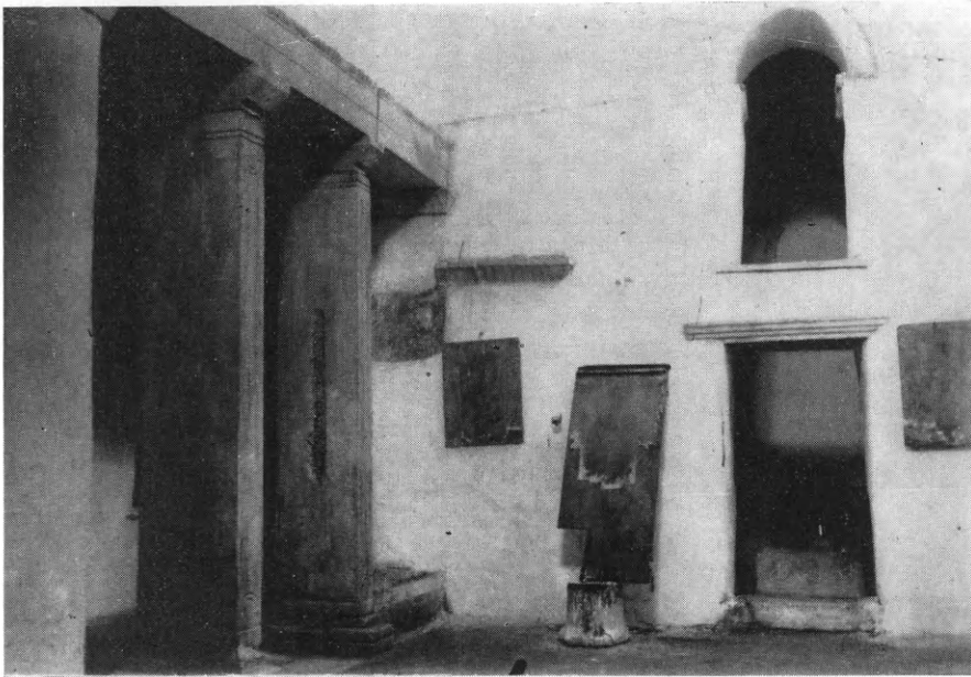
Εἰκ. 192. Ὁ πρὸ τῶν ἐργασιῶν ἀναστηλώσεως ὑφιστάμενος διαχωριστικὸς τοῖχος μεταξὺ τοῦ κυρίως βαπτιστηρίου καὶ τοῦ προθαλάμου του τοῖχος.
