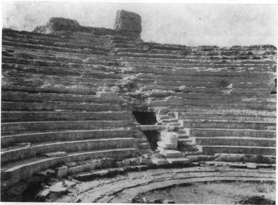
Είκ. 186. Τὸ κοῖλον τοῦ Ὁδείου τῆς Νικοπόλεως μετὰ τὰς ἐργασίας συμπληρώσεως τῶν ἐδωλίων του.
