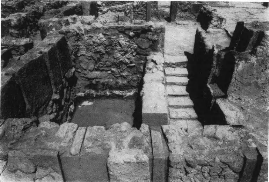
Εἰκ. 170. Ἡ καθαρτήριοι δεξαμενῆς τοῦ Ἱεροῦ, μετὰ τὴν στερέωσιν καὶ ἀποκατάστασίν της.
