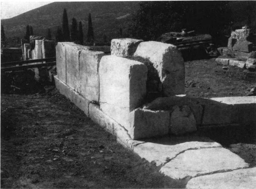
Εἰκ. 115. Ὅψεις τῆς ἐξωτερικῆς παρεϊᾶς τοῦ διαμερίσματος Υ μετὰ τὴν ἀναστήλωσιν τῶν ὀρθοστατῶν.
