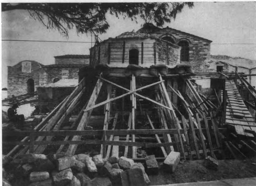
Εικ. 211. Ὑποστήλωσις τοῦ τρούλλου τοῦ Βαπτιστηρίου χάριν ἀνακατασκευῆς τῆς καμάρας τοῦ νοτίου κλίτους αὐτοῦ.
