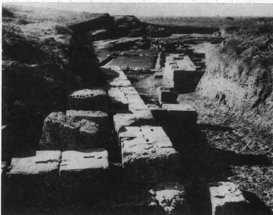
Εἰκ. 130. Τὸ ἀνάλημμα τῆς Α. παρόδου τοῦ θεάτρου τῆς Ἡλίδος μετὰ τὴν ἀποκατάστασιν αὐτοῦ.
