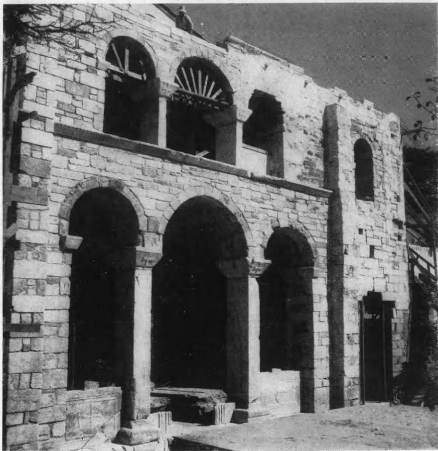
Εἰκ. 219. Τὸ τρίβηλον τοῦ ἰσογείου καὶ τὸ τρίλοβον παράθυρον τοῦ γυναικωνίτου τῆς Καταπολιανῆς μετὰ τὰς ἐργασίας ἀναστηλώσεως αὐτῆς.
