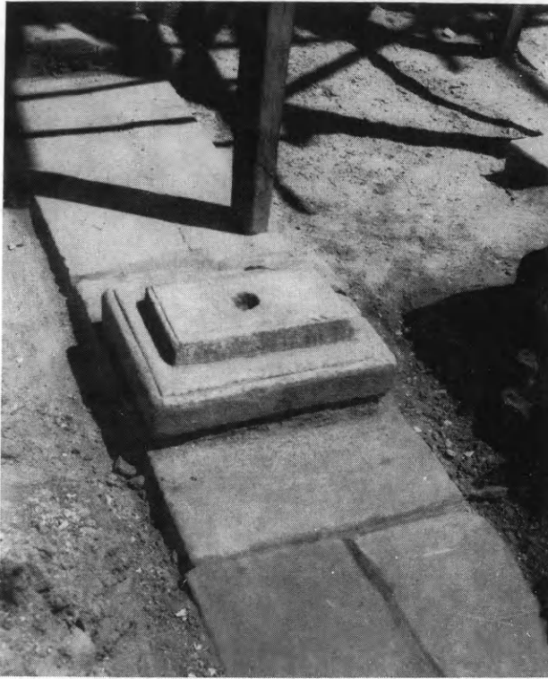
Εἰκ. 220. Ὁ ἀποκαλυφθεὶς στυλοβάτης τοῦ αἰθρίου τῆς παλαιότερας βασιλικῆς τῆς Καταπολιανῆς Πάρου μετὰ τῆς κατὰ χώραν εὐρεθείσης βάσεως πεσσοῦ.
