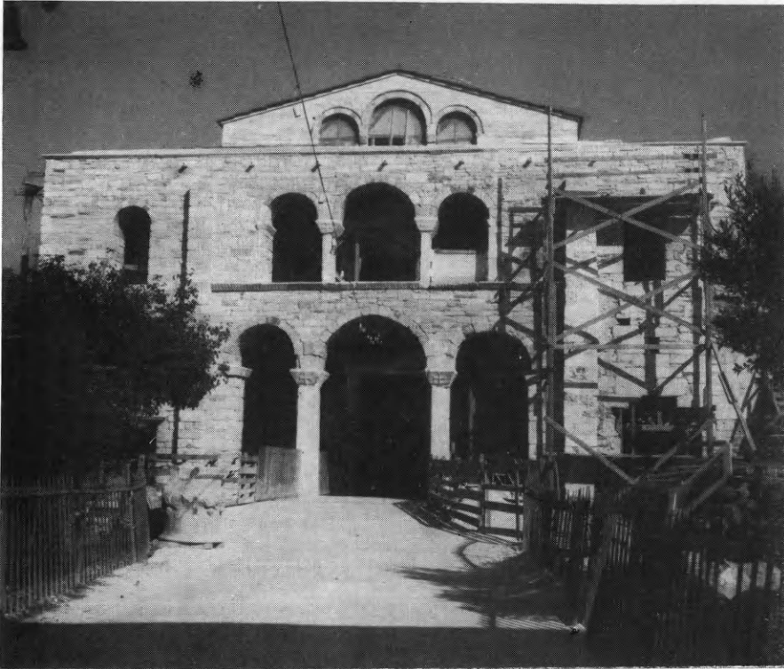
Εἰκ. 217. Ἐπιφάνεια τῆς προσόψεως τοῦ ναοῦ τῆς Καταπολιανῆς μετὰ τὰς ἐργασίας ἀναστήλωσεως αὐτῆς.
