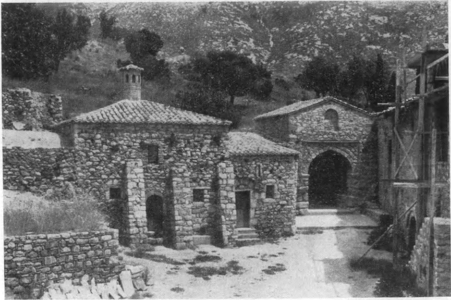
Εἰκ. 256. Ἄποψις τοῦ πυλῶνος καὶ τοῦ φωτανάματος ἐκ τοῦ ἐσωτερικοῦ τῆς μονῆς μετὰ τὰς ἐργασίας ἀναστηλώσεως.
