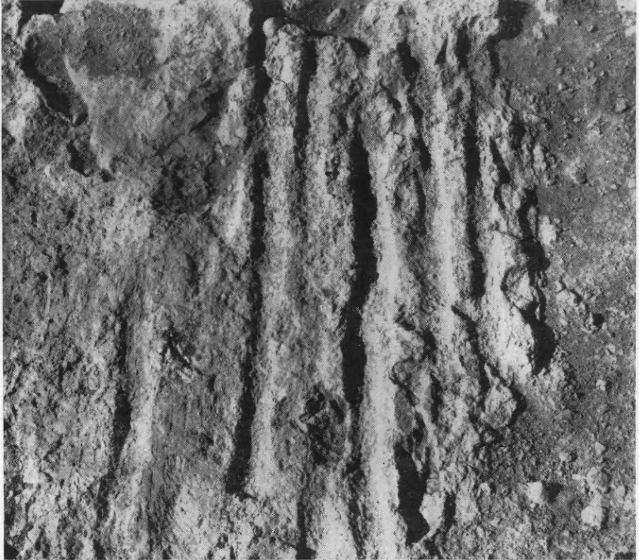
Εἰκ. 150. Ἀποτυπώματα δοκαρίων συγκρατούντων τὸ κονίαμα τοῦ τοίχου.
