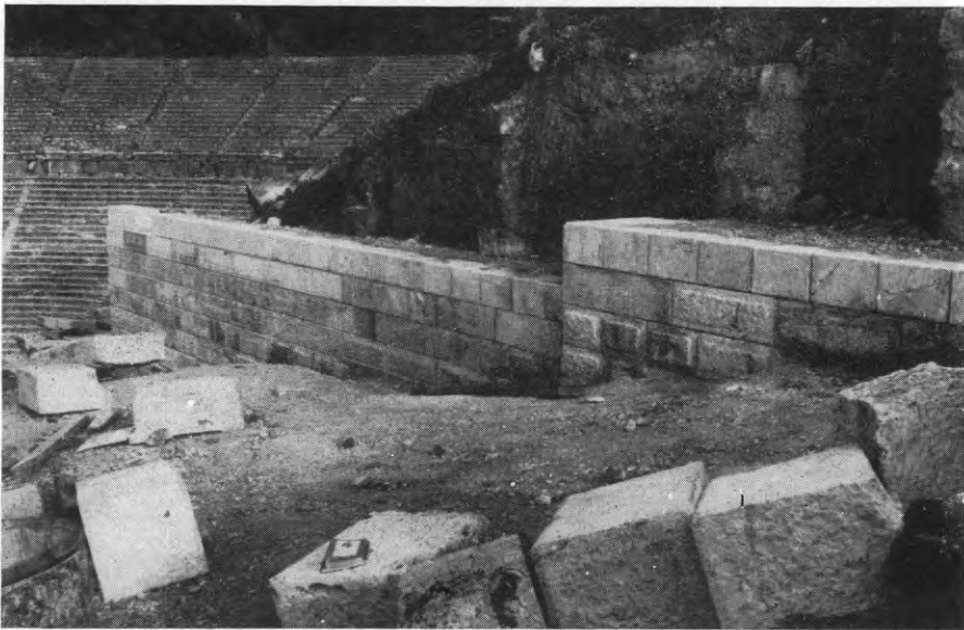
Εικ. 252 και 253. Τὸ Δ. ἀνάλημμα τοῦ ἄνω διαζώματος τοῦ θεάτρου τῆς Ἐπιδαύρου πρὸ καὶ μετὰ τὴν ἀναστήλωσιν αὐτοῦ.
