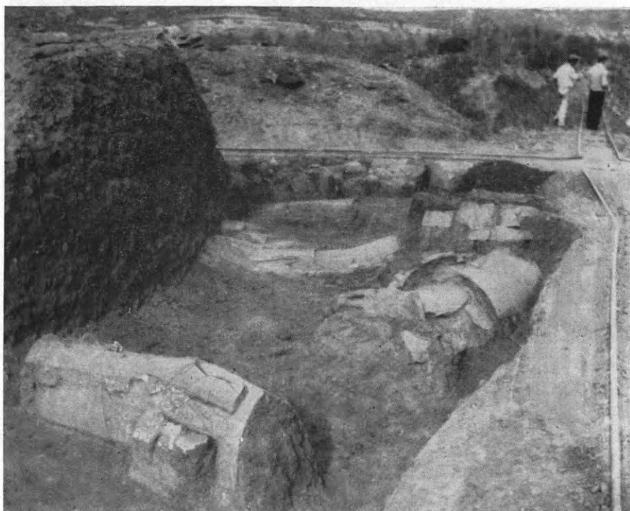
Εἰκ. 186. Σαμαρωτοὶ τάφοι εὐθὺς μετὰ τὴν ἀποκάλυψίν των.
