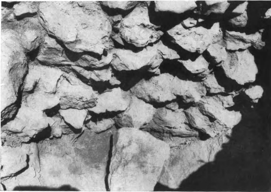
Εἰκ. 152. Τεχνητὸν γέμισμα ἐξ ἀργῶν λίθων σχηματίζον ἄνδηρον.
