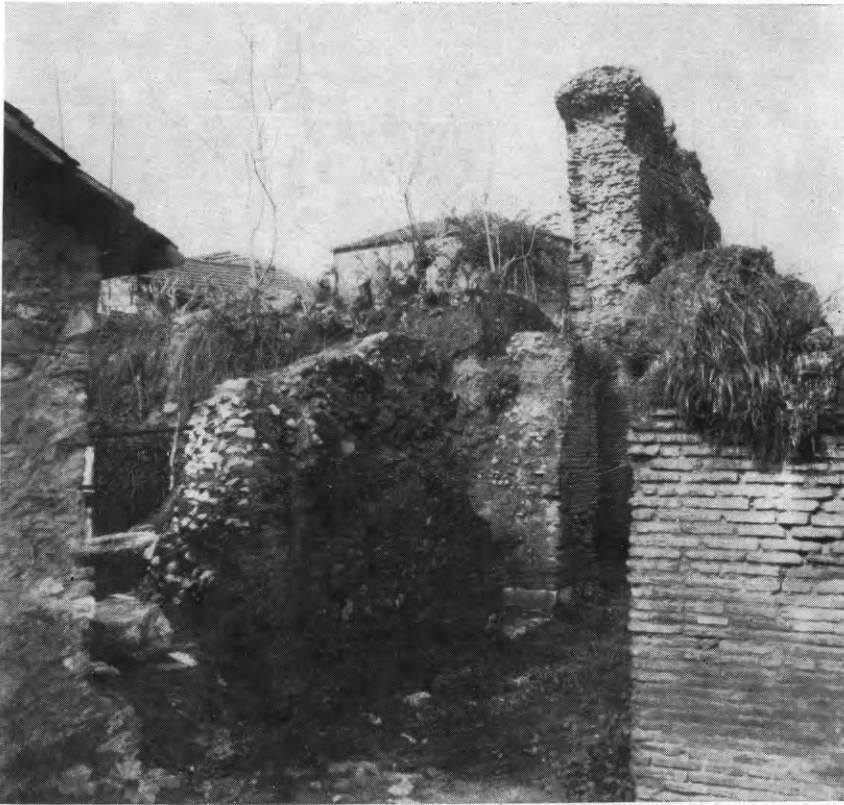
Εἰκ. 250. Οἱ ἐξωτερικοὶ τοῖχοι τοῦ Ὁδείου Πατρῶν πρὸ τῶν ἐργασιῶν ἀναστήλωσεως.
