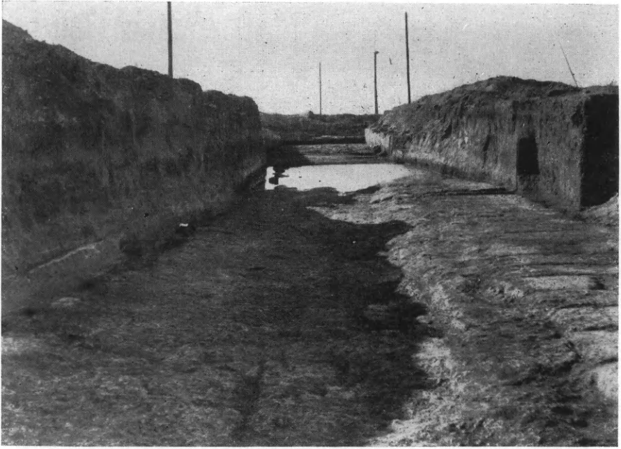
Εἰκ. 131. Ἡ ἀποκαλυφθεῖσα εἰς τὴν δυτικὴν ἀφετηρίαν τοῦ διόλκου πρόσθετος κατασκευὴ ἐξ ἀνατολῶν.
