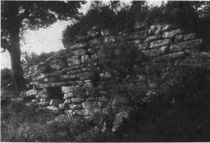
Εἰκ. 162. Ἑλληνικὸ Μουριατάδας. Πύργος ἢ ἀνάλημμα κυκλωπέιου κατασκευῆς.
