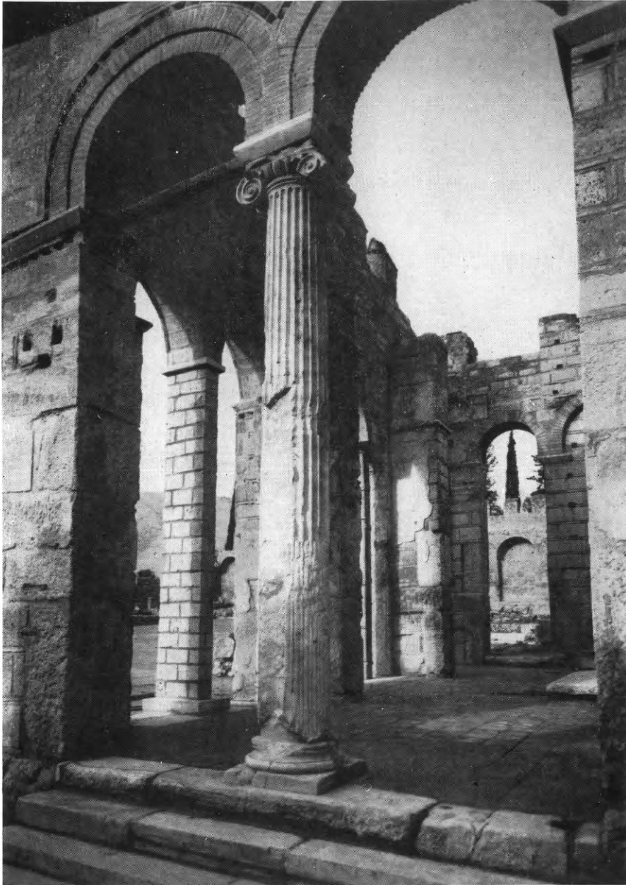
Εἰκ. 270. Ὁψίς τοῦ ἐσωτερικοῦ τοῦ ἐξωνάρθηκος τοῦ καθολικοῦ τῆς Μ. Δαφνίου μετὰ τὰς ἐργασίας ἀποκαταστάσεως αὐτοῦ.
