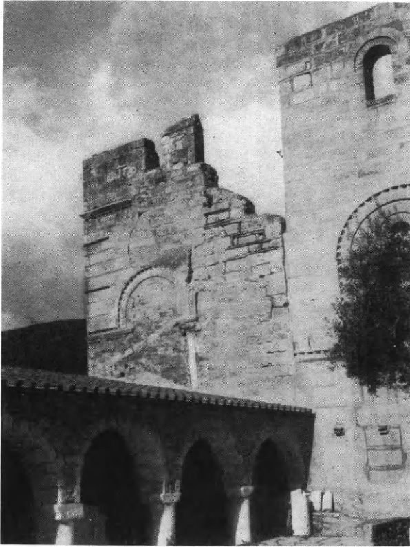
Εἰκ. 268. Ἀποψὶς τῆς νοτίας πλευρᾶς τοῦ ἐξωνάρθηκος τοῦ ναοῦ τοῦ Δαφνίου πρὸ τῶν ἐργασιῶν ἀποκαταστάσεως αὐτῆς.
