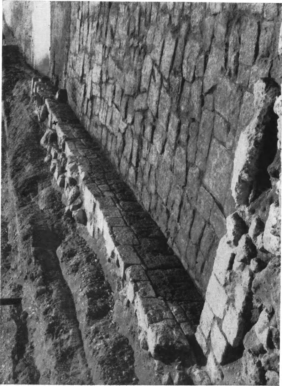
Εἰκ. 132. Ὁ βόρειος καὶ ὁ δυτικὸς ἀναλημματικὸς τοῖχος εἰς τὴν δυτικὴν ἀφῆτηρίαν τοῦ διόλκου.
