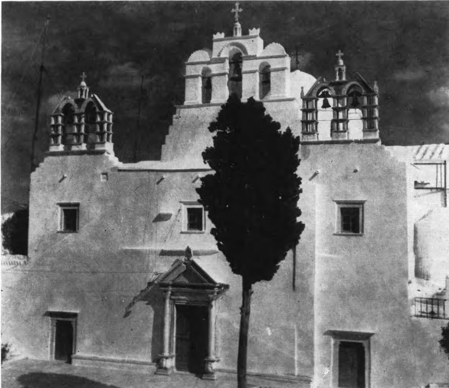
Εἰκ. 285. Ἡ πρόσοψις τοῦ ναοῦ τῆς Καταπολιανῆς πρὸ τῶν ἐργασιῶν ἀποκαταστάσεως αὐτῆς.
