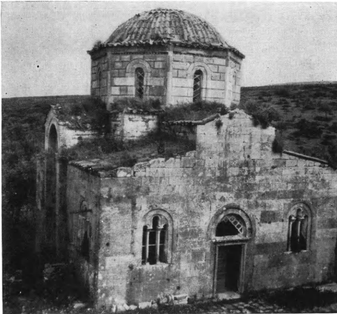
Εἰκ. 276. Ὁ Ἅγιος Νικόλαος «στὰ Καμπιά» πρὸ τῶν ἐργασιῶν καθαρισμοῦ καὶ στερεώσεως αὐτοῦ.
